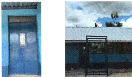
Foto 3: Puertas de sanitarios, aulas y portón instalado
