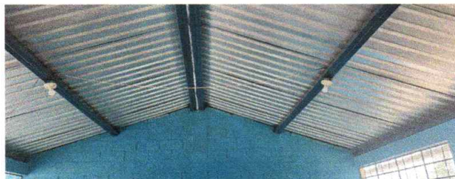
Foto 2: Estructura de soporte instalada
