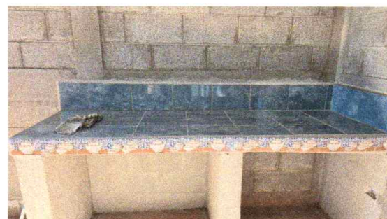
Foto 4: Reparación de cocina culminada
