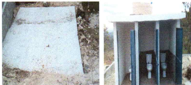
Foto 5: Fosa séptica y sanitarios terminados
