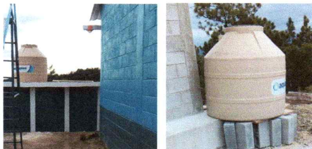
Foto 1: Depósitos de agua instalados
