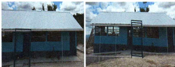
Foto 1: Cubierta de lámina instalada
