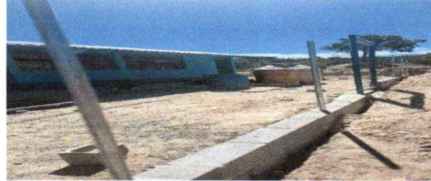
Foto 6: Realizando muro perimetral dañado
