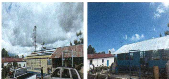
Foto 1: Instalando cubierta de lámina
