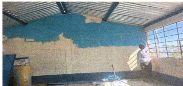
Foto 2: Aplicación de pintura en centro educativo
