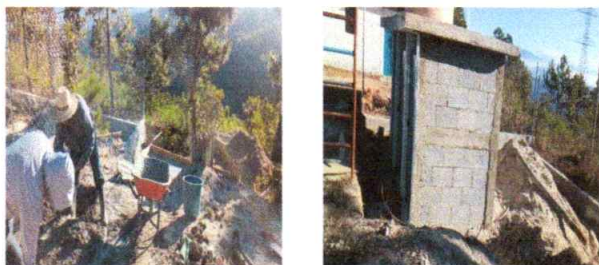
Foto 5: Realizando fosa séptica y servicios sanitarios
