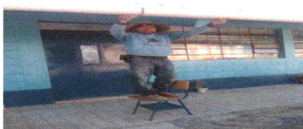
Foto 4: Instalando canal de pvc
