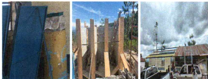
Foto 3: Instalando puertas en servicios sanitarios y aulas
