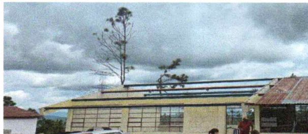
Foto 2: Instalando cubierta de lámina
