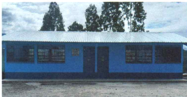
Foto1: Cubierta de lámina instalada
