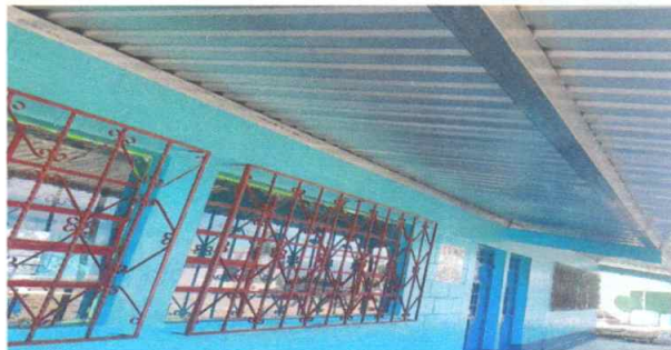
Foto 2: Estructura de soporte de metal instalada
