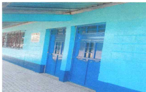
Foto 3: Puertas de metal de aulas instaladas
