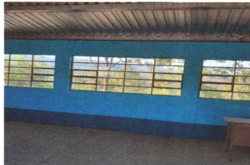
Foto 4: Vidrios en ventanas de aulas instalados
