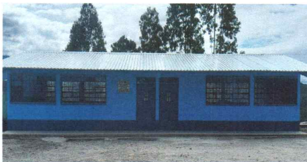
Foto1: Cubierta de lámina instalada
