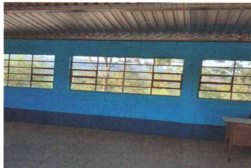
Foto 4: Vidrios en ventanas de aulas instalados
