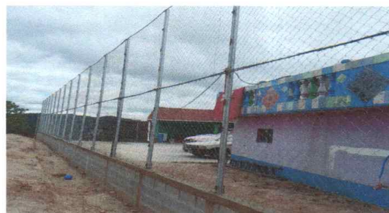
Foto 6: Muro perimetral terminado
