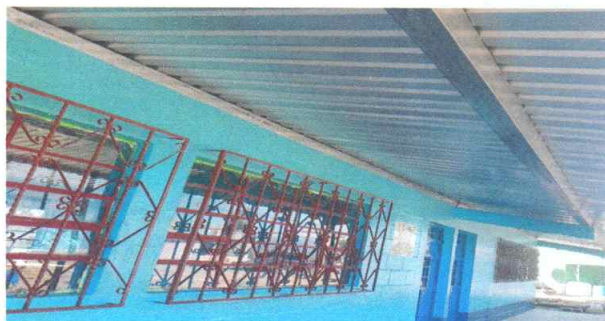
Foto 2: Estructura de soporte de metal instalada
