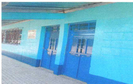
Foto 3: Puertas de metal de aulas instaladas
