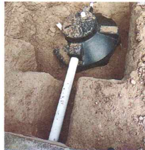
Foto 8: Reparación de red de drenaje y biodigestor instalado
