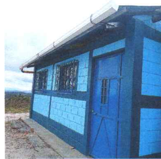
Foto 6: Canales y bajadas de agua pluvial instaladas
