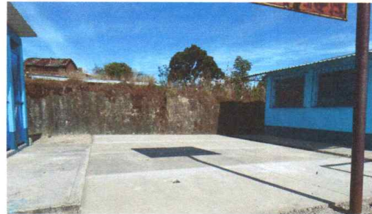
Foto 9: Losa de patio concluida
