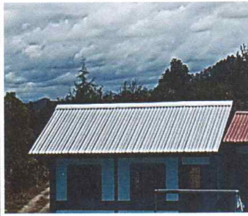
Foto 1: Cubierta de lámina instalada
