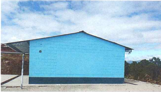
Foto 6: Pintura en muros exteriores e interiores aplicada
