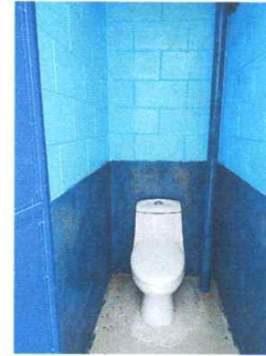
Foto 7: Sanitarios y sus accesorios instalados
