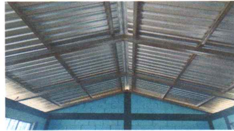
FOTO 2: Estructura de techo instalada
