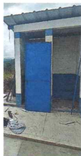
Foto 3: Instalación de puertas
