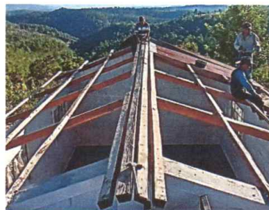
FOTO 2: Colocación de estructura de techo
