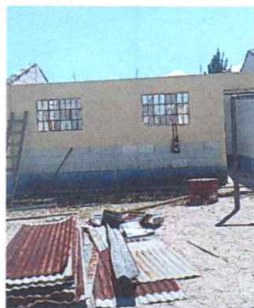
Foto 1: Instalación de lámina
