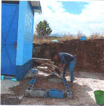
FOTO 11: Instalación de depósito de agua
