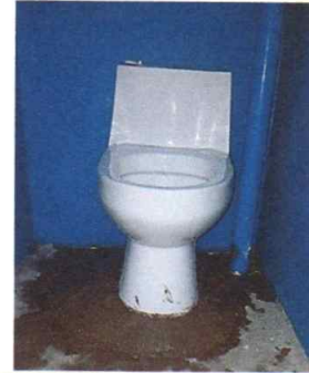
FOTO 7: Instalación de sanitarios y sus accesorios
