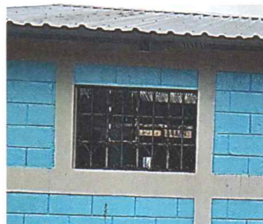
Foto 4: Instalación de ventanas
