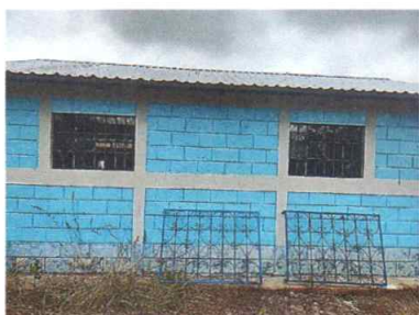
Foto 5: Instalación de balcones
