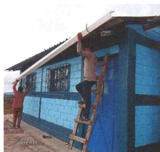
Foto 6: Instalación de canales y bajadas de agua pluvial
