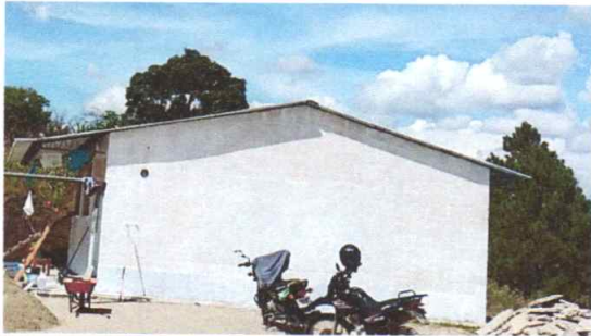
Foto 6: Aplicación de pintura en muros exteriores e interiores
