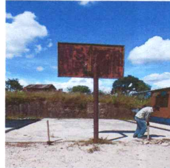
Foto 9: Reparación de losa de patio
