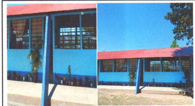
Foto 4: Pintura en muros interiores y exteriores aplicada
