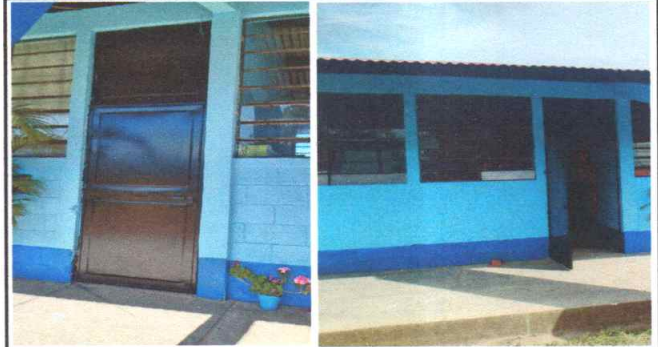
Foto 2: Puertas de metal de cada clase instaladas
