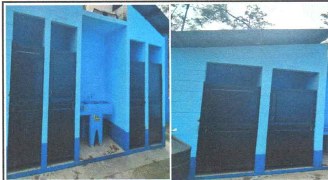
Foto 3: Puertas de servicios sanitarios instalados
