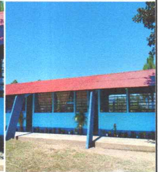
Foto 2: Las láminas del techo con mantenimiento aplicado
