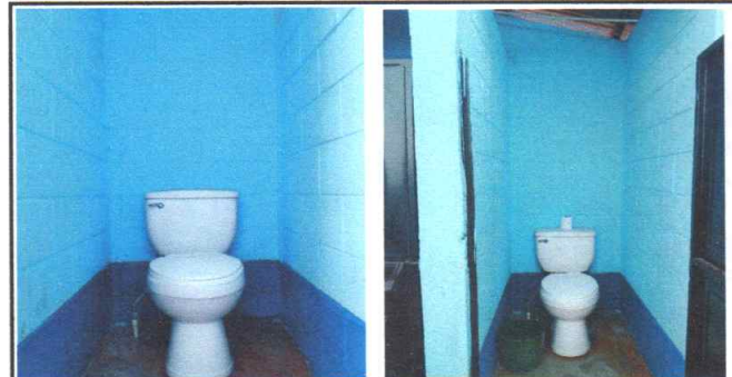
Foto 6: Baños con accesorios de tanque de agua y reconección de agua potable para tanque instalados
