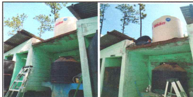
Foto 5: Instalando depósito de agua
