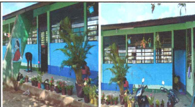
Foto 4: Aplicando pintura en muros interiores y exteriores
