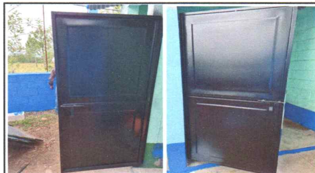
Foto 3: Instalando puertas de servicios sanitarios
