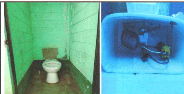
Foto 6: Instalando en baños accesorios de tanque de agua y reconexión de agua potable para tanque
