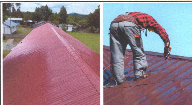
Foto 2: Aplicando mantenimiento a láminas del techo
