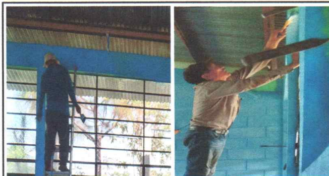
Foto 3: Aplicando mantenimiento a estructura de soporte
