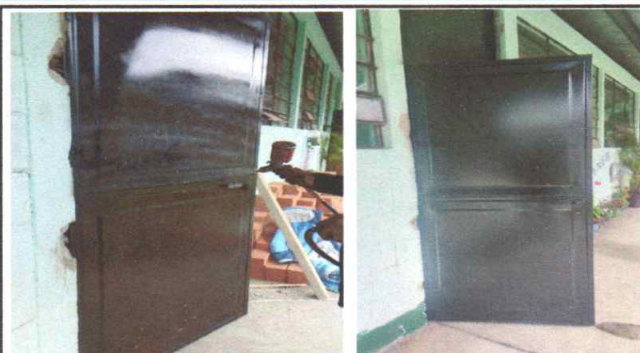
Foto 2: Instalando puertas de metal de cada clase
