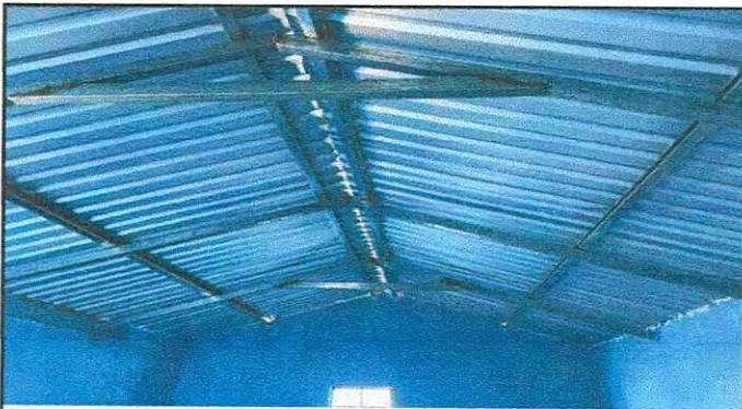
Foto 3: ESTRUCTURA DE TECHO
