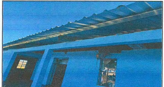
Foto 2: CUBIERTA DE LÁMINA
