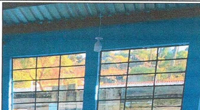
Foto 14: REPARACIÓN DEL SISTEMA ELÉCTRICO
