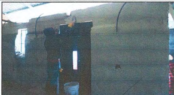
Foto 13: REPARACIÓN DEL SISTEMA ELECTRICO
