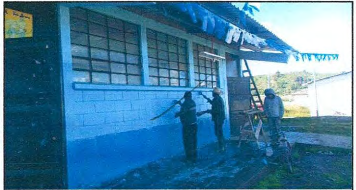
Foto 10: PINTURA EN MUROS EXTERIORES
