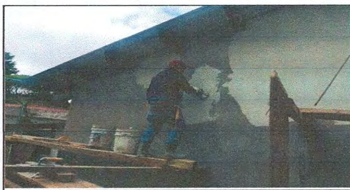
Foto 17: REPARACION DE REPELLO Y CERNIDO DE PAREDES
