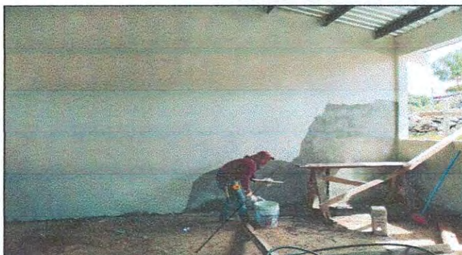
Foto 16: REPARACION DE REPELLO Y CERNIDO DE PAREDES
