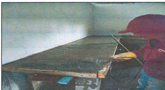
Foto 15: REPARACION DE COCINA (MEJORAMIENTO DE MESA DE CONCRETO)
