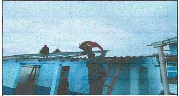
Foto 2: CUBIERTA DE LÁMINA
