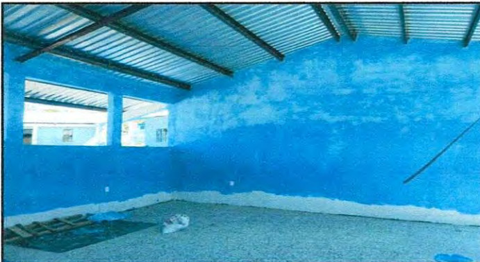
Foto 9: PINTURA EN MUROS INTERIORES
