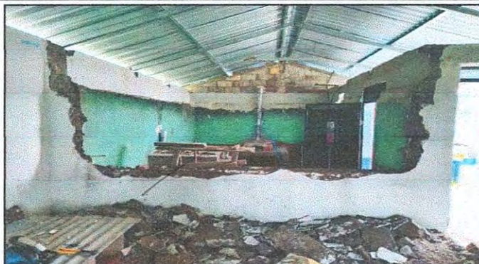
Foto 14: REPARACION DE COCINA
