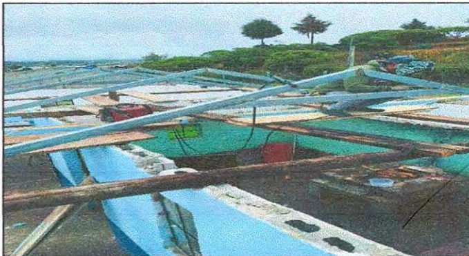
Foto 3: ESTRUCTURA DE TECHO
