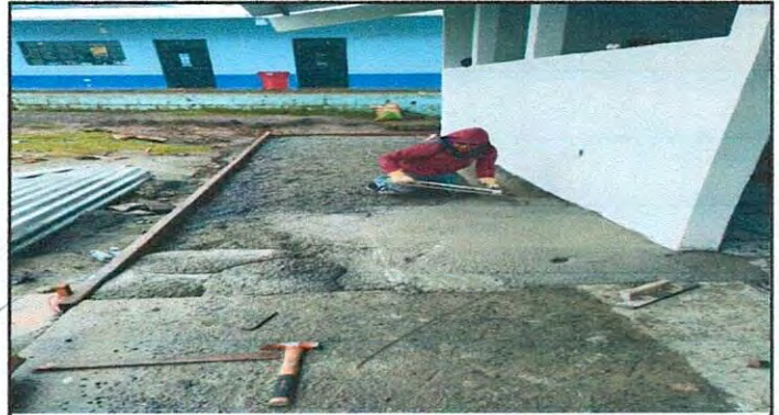
Foto 8: BANQUETA DE CONCRETO (MEJORAMIENTO DE BANQUETA DE CONCRETO)
