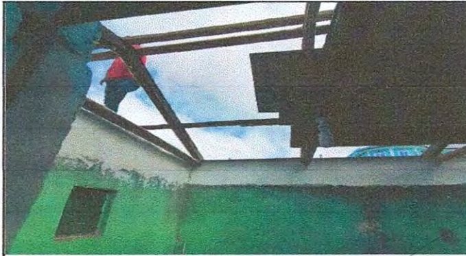
Foto 1: CUBIERTA DE LÁMINA
