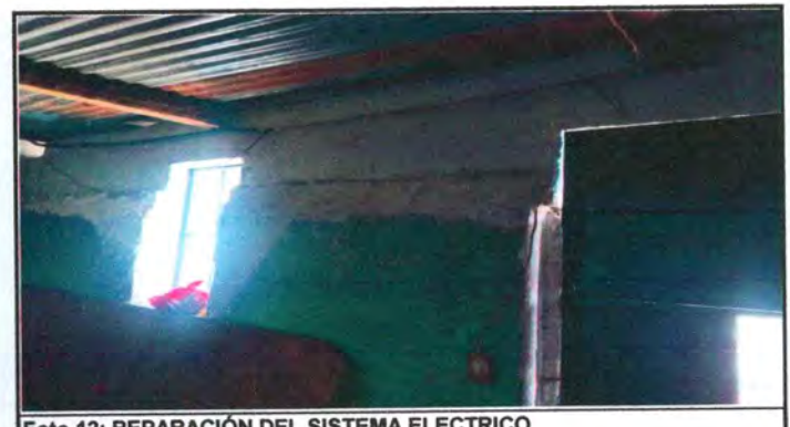
Foto 12: REPARACIÓN DEL SISTEMA ELECTRICO
