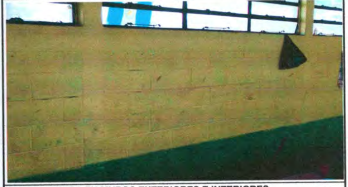
Foto 8: PINTURA EN MUROS EXTERIORES E INTERIORES
