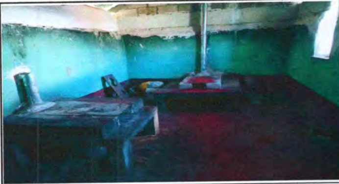
Foto 13: REPARACION DE COCINA
