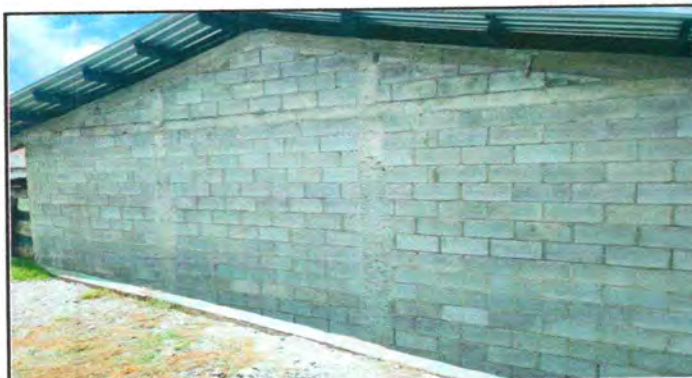
Foto 15: REPARACION DE REPELLO Y CERNIDO DE PAREDES
