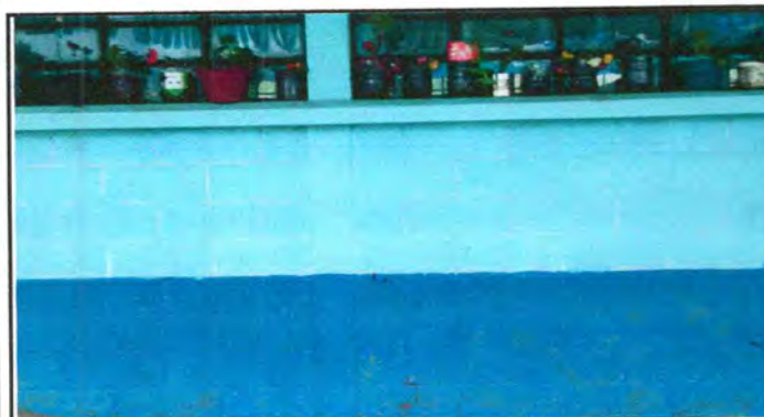
Foto 9: PINTURA EN MUROS EXTERIORES E INTERIORES
