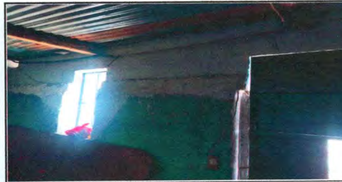
Foto 12: REPARACIÓN DEL SISTEMA ELECTRICO
