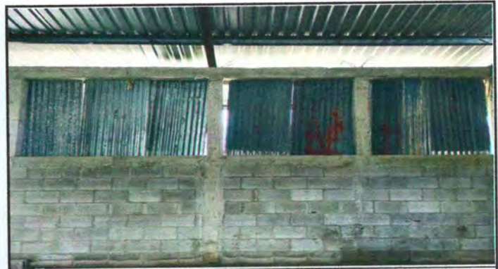
Foto 16: REPARACION DE REPELLO Y CERNIDO DE PAREDES
