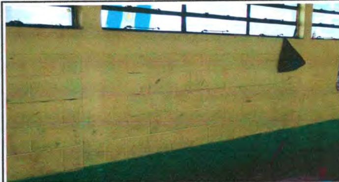
Foto 8: PINTURA EN MUROS EXTERIORES E INTERIORES
