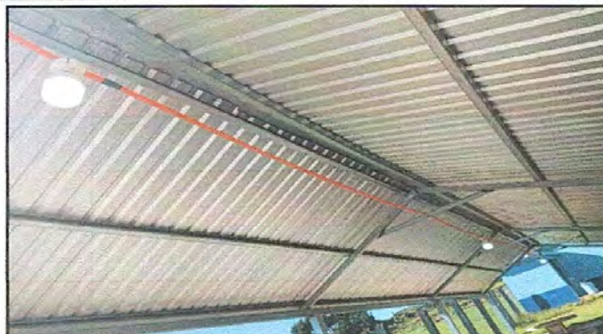
Foto 2: SUSTITUCIÓN DE CABLEADO Y PLAFONERAS
