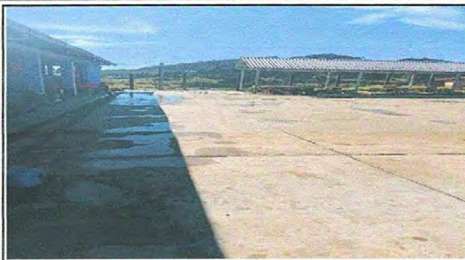
Foto 2: LOSA DE PATIO
