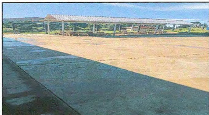
Foto 3: LOSA DE PATIO
