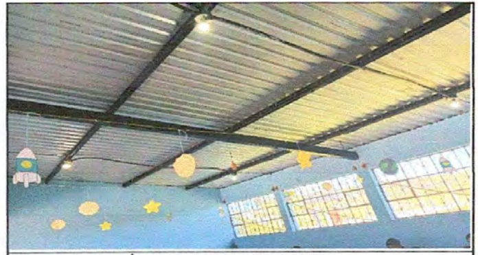
Foto 6: SUSTITUCIÓN DE FOCOS AHORRADORES
