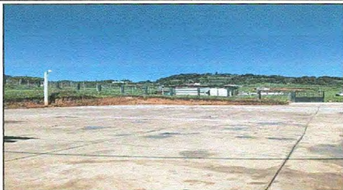
Foto1: LOSA DE PATIO
