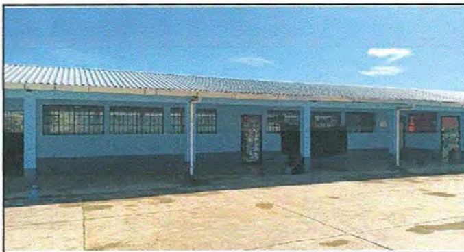
Foto 6: PINTURA EN MURO EXTERIOR
