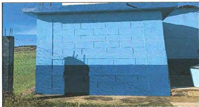
Foto 5: PINTURA EN MURO EXTERIOR
