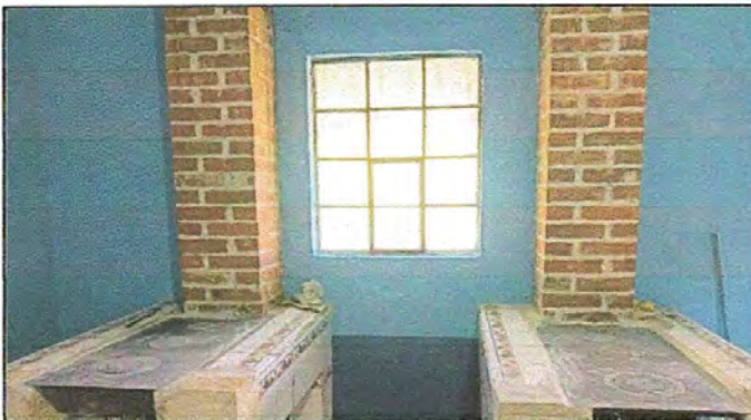
Foto 3: SUSTITUCIÓN DE PLANCHA DE METAL DE 3 DISCOS
