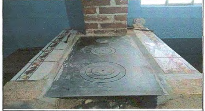
Foto 2: SUSTITUCIÓN DE PLANCHA DE METAL DE 3 DISCOS
