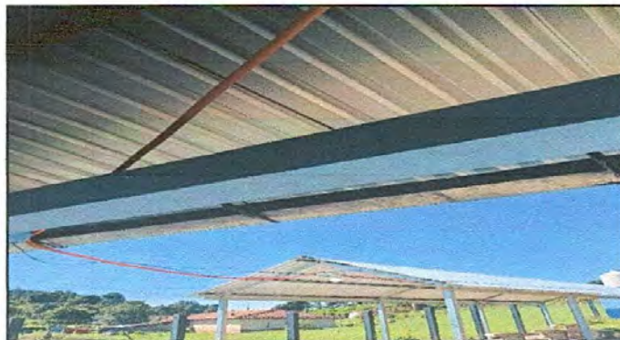
Foto 4: SUSTITUCIÓN DE CABLEADO Y PLAFONERAS
