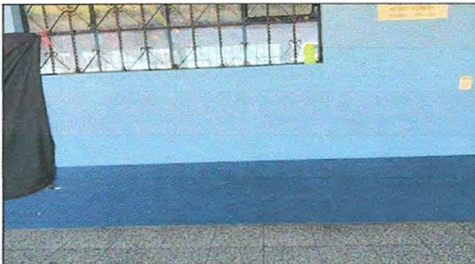
Foto 4: PINTURA EN MURO EXTERIOR
