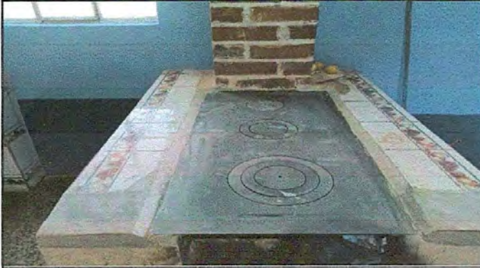
Foto 1: SUSTITUCIÓN DE PLANCHA DE METAL DE 3 DISCOS
