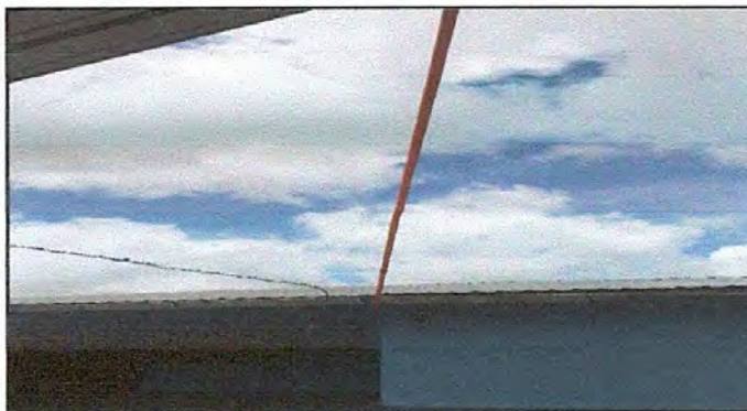
Foto 3: SUSTITUCIÓN DE CABLEADO Y PLAFONERAS
