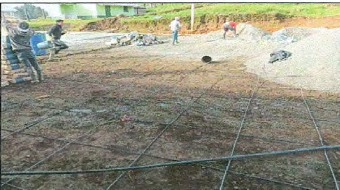
Foto 3: LOSA DE PATIO
