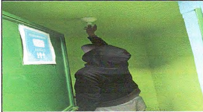
Foto1: SUSTITUCIÓN DE FOCOS AHORRADORES
