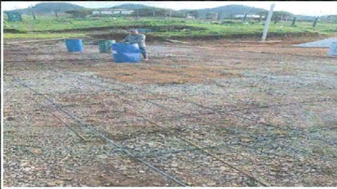
Foto1: LOSA DE PATIO
