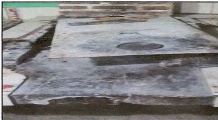
Foto 1: SUSTITUCIÓN DE PLANCHA DE METAL DE 3 DISCOS
