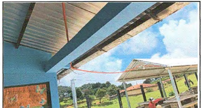
Foto 4: SUSTITUCIÓN DE CABLEADO Y PLAFONERAS
