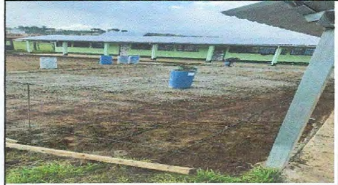
Foto 2: LOSA DE PATIO
