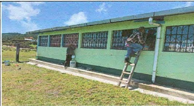
Foto 5: PINTURA EN MURO EXTERIOR
