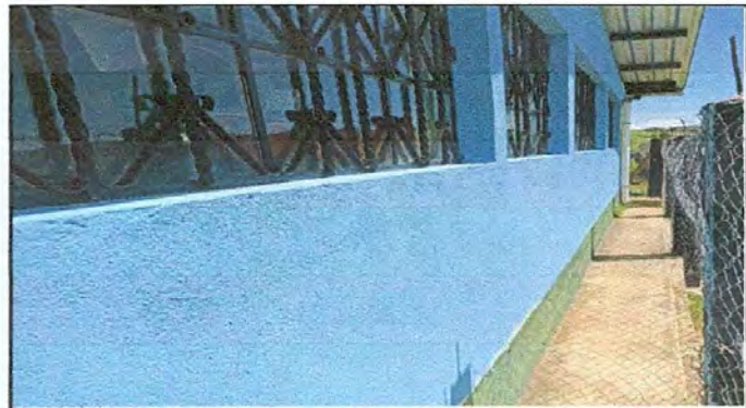
Foto 4: PINTURA EN MURO EXTERIOR
