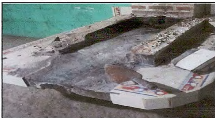
Foto 3: SUSTITUCIÓN DE PLANCHA DE METAL DE 3 DISCOS
