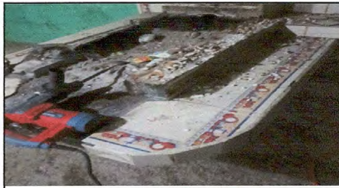
Foto 2: SUSTITUCIÓN DE PLANCHA DE METAL DE 3 DISCOS
