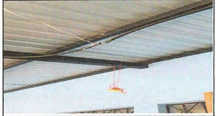
Foto 2: SUSTITUCIÓN DE CABLEADO Y PLAFONERAS
