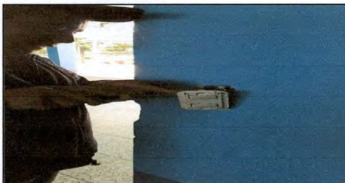
Foto 5: SUSTITUCIÓN DE APAGADOR DOBLE
