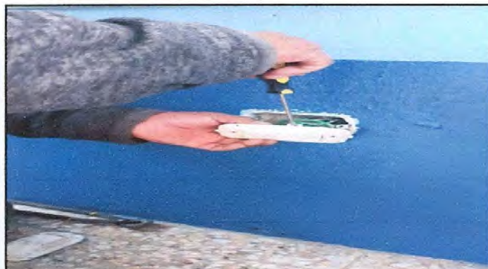
Foto 4: SUSTITUCIÓN DE TOMACORRIENTE DOBLE
