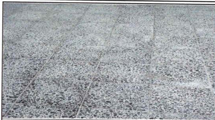
FOTO 1: SUSTITUCION DE PISO GRANITO
