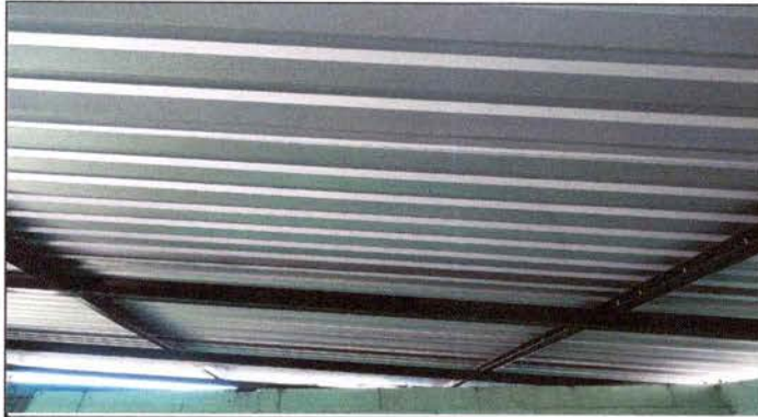
FOTO 1: SUSTITUCION DE ESTRUCTURA DE MADERA POR METAL
