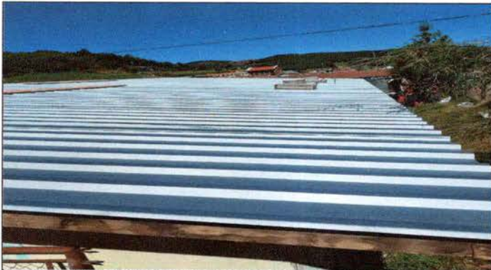
FOTO 3: SUSTITUCION DE LAMINA POR LAMINA TROQUELADA
