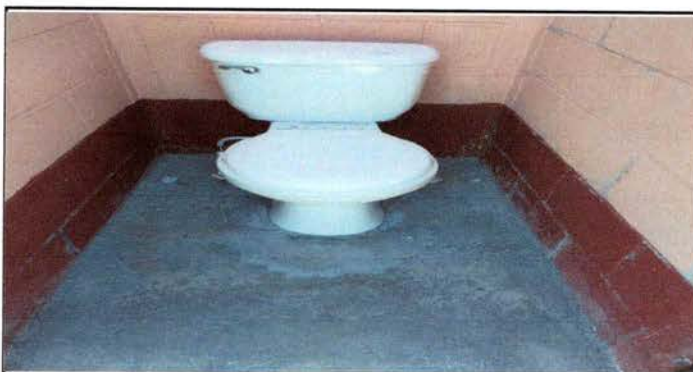
FOTO 5: SUSTITUCION DE INODOROS
