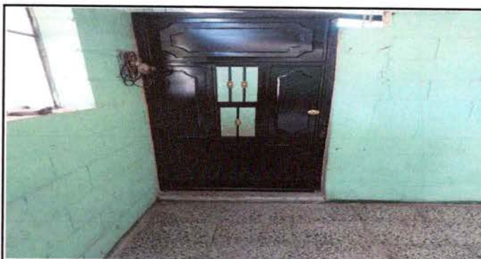
FOTO 6 : SUSTITUCION DE PUERTA DE MADERA POR METAL
