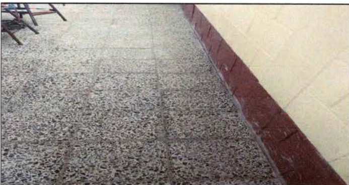
FOTO 5 : SUSTITUCION DE PISO GRANITO
