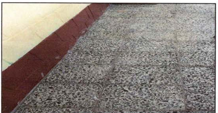
FOTO 6: SUSTITUCION DE PISO GRANITO
