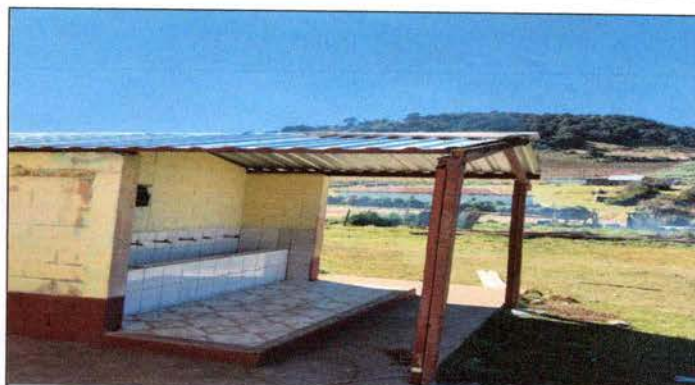
FOTO 5: SUSTITUCION DE TECHO Y ESTRUCTURA
