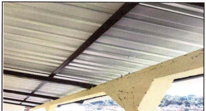
FOTO 4: SUSTITUCION DE LAMINA POR LAMINA TROQUELADA
