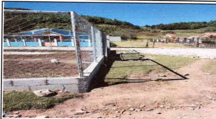
FOTO 2 : SUSTITUCION DE CIRCULACION
