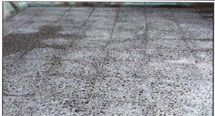
FOTO 2: SUSTITUCION DE PISO POR PISO GRANITO
