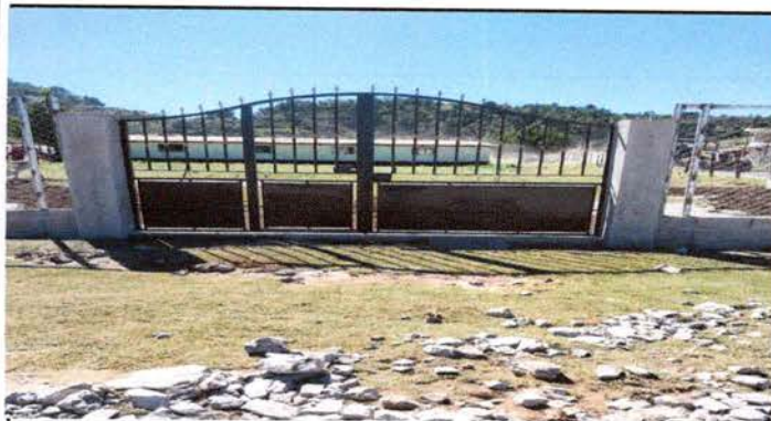
FOTO 3: SUSTITUCION DE PORTON
