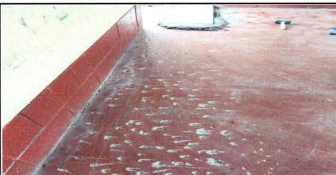
FOTO 5: SUSTITUCION DE PISO GRANITO
