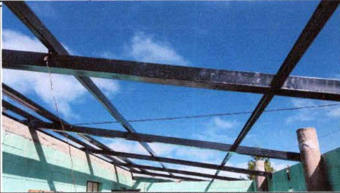
FOTO 1: SUSTITUCION DE ESTRUCTURA DE MADERA POR METAL
