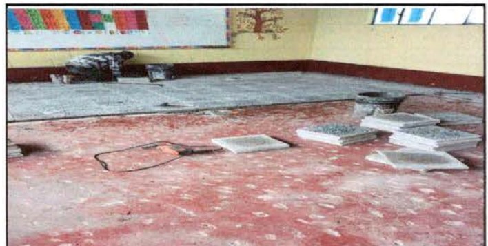
FOTO 6: SUSTITUCION DE PISO GRANITO
