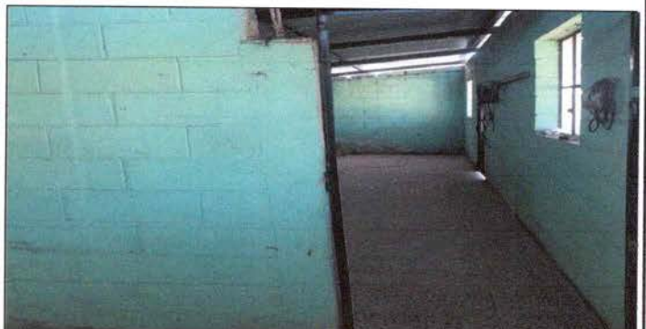
FOTO 6 : SUSTITUCION DE PUERTA DE MADERA POR METAL
