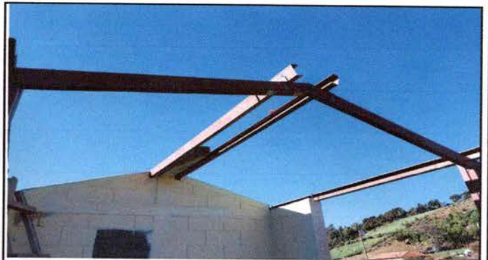
FOTO 5: SUSTITUCION DE TECHO Y ESTRUCTURA
