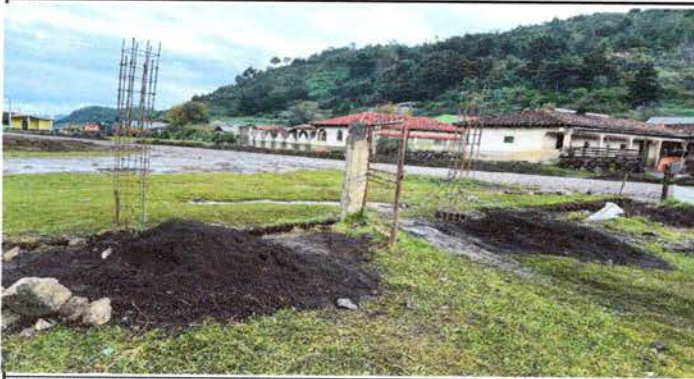
FOTO 3: SUSTITUCION DE PORTON
