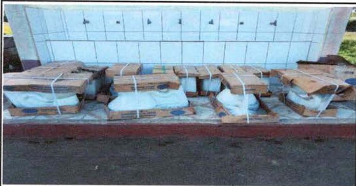
FOTO 5: SUSTITUCION DE INODOROS
