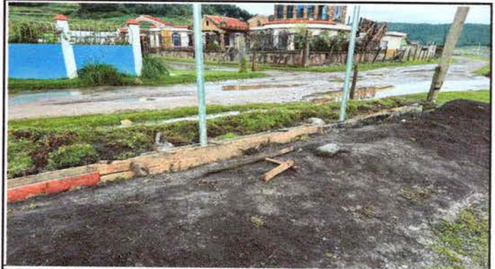
FOTO 2 : SUSTITUCION DE CIRCULACION
