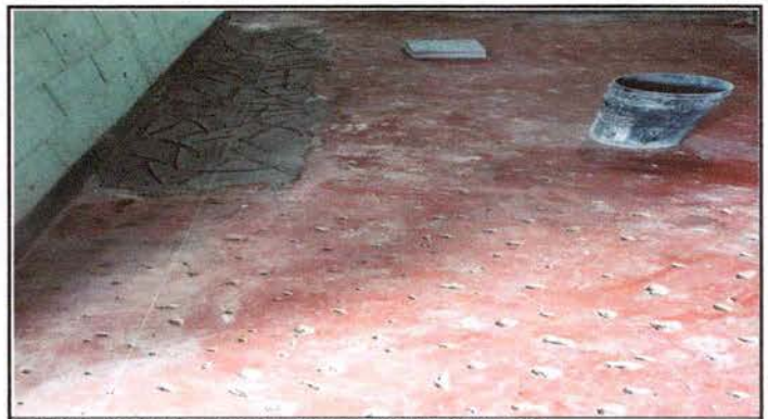
FOTO 2: SUSTITUCION DE PISO POR PISO GRANITO
