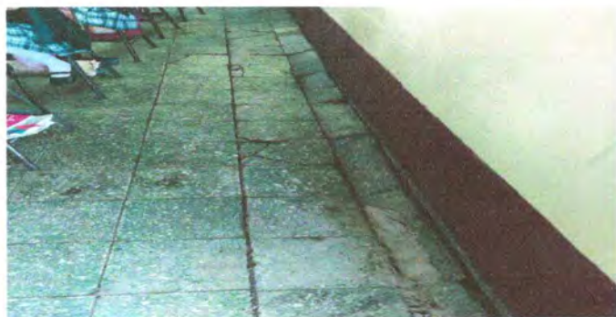
FOTO 5: SUSTITUCION DE PISO GRANITO
