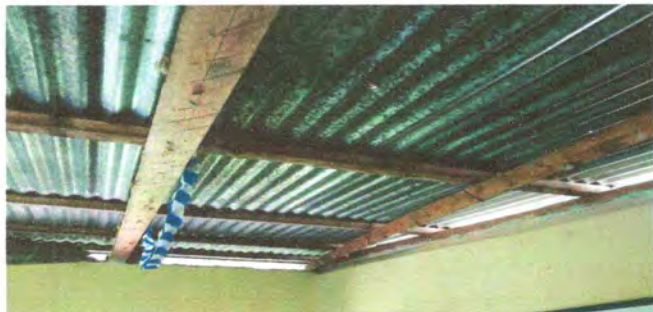
FOTO 1: SUSTITUCION DE ESTRUCTURA DE MADERA POR METAL
