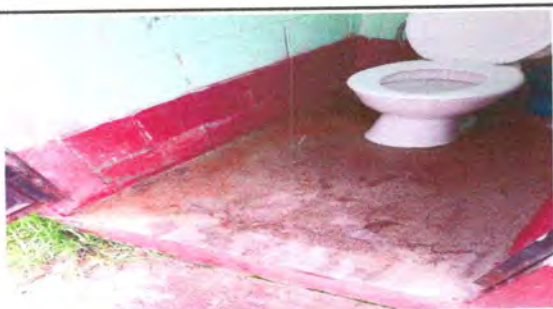
FOTO 5: SUSTITUCION DE INODOROS
