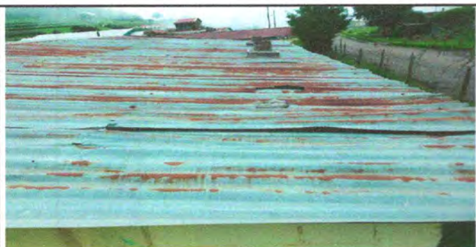
FOTO 3: SUSTITUCION DE LAMINA POR LAMINA TROQUELADA
