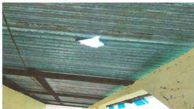
FOTO 4: SUSTITUCION DE LAMINA POR LAMINA TROQUELADA
