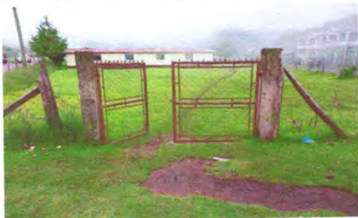
FOTO 3: SUSTITUCION DE PORTON
