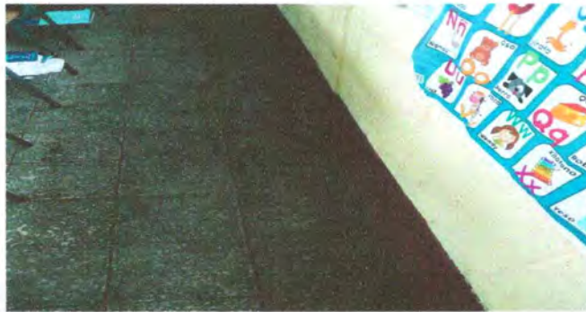
FOTO 6: SUSTITUCION DE PISO GRANITO
