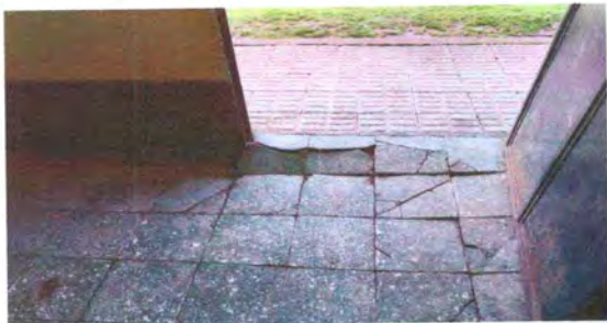
FOTO 1: SUSTITUCION DE PISO GRANITO
