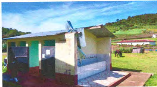
FOTO 5: SUSTITUCION DE TECHO Y ESTRUCTURA
