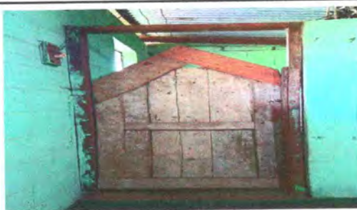
FOTO 6 SUSTITUCION DE PUERTA
