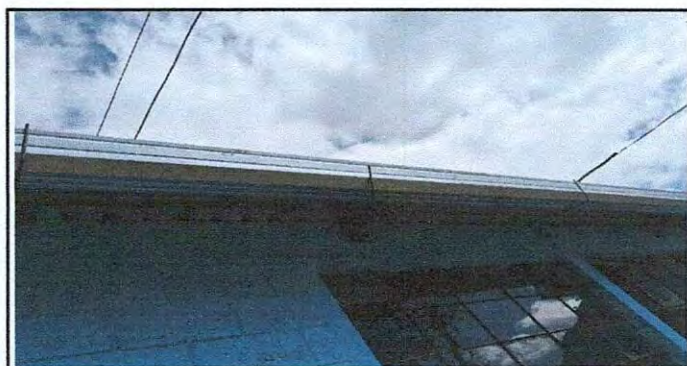
Foto 6: Instalación de canales de metal.
