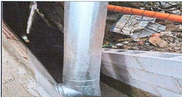
Foto 13: Colocación de chimenea de metal en cocina.
