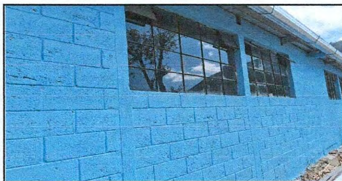
Foto 5: Pintura de paredes exteriores.
