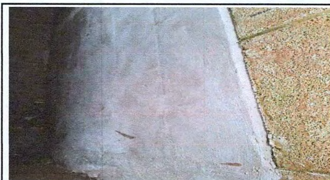
Foto 16: Repello de pared exterior.
