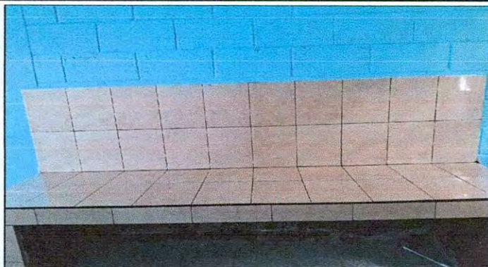
Foto1: Colocación de ceramico en cocina
