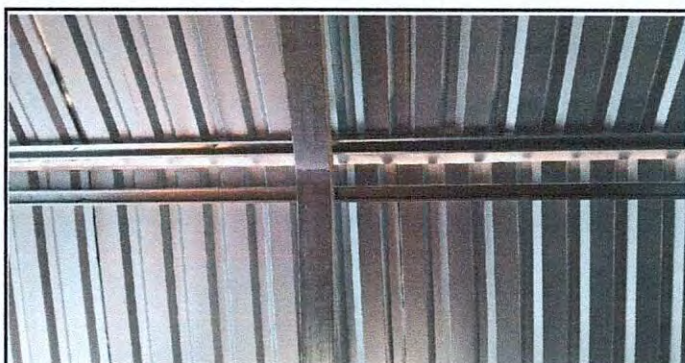
Foto 12: Instalación de costaneras y lámina.
