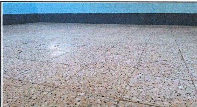
Foto 9: Colocación de granito en aula.
