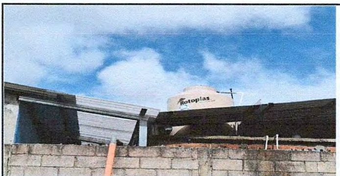
Foto 17: Instalación de depósito de agua.
