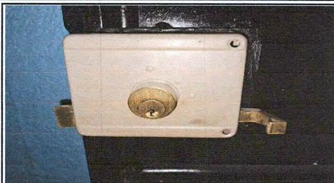
Foto 14: Colocación de chapa Yale.
