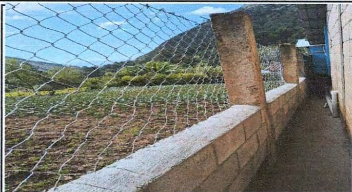
Foto 7: Colocación de malla en muro.
