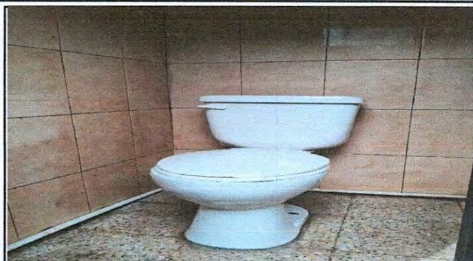
Foto 2: Trabajo de baño finalizado.
