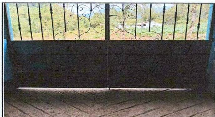
Foto 4: Pintura de Portón.
