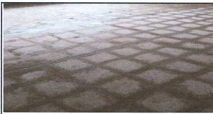
Foto 17: Colocación de piso granito.
