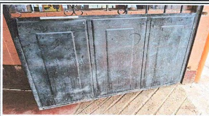
Foto 14: Lijado de puertas.
