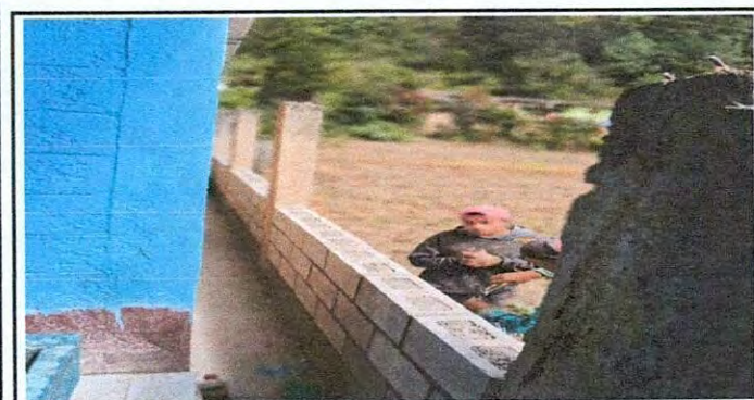
Foto 5: Iniciando a levantar muro
