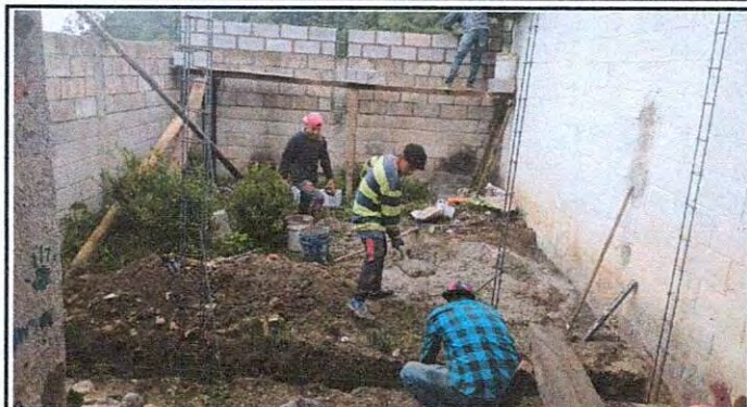
Foto 13: Inicio de construcción y mejoramiento de aula.
