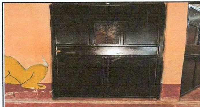
Foto 3: iniciando a pintar puertas.
