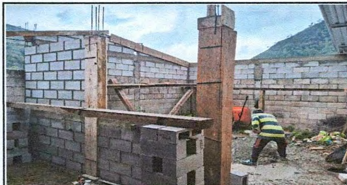
Foto1: iniciando a completar paredes
