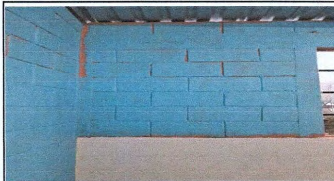
Foto 10: Repello de pared interior.
