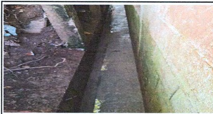
Foto 15: Limpieza de cuneta y pared, para levantar muro.
