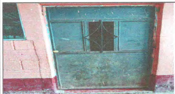
Foto 9: Mantenimiento a estructura de puerta
