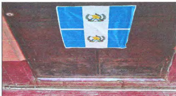
Foto 12: Sustrucción de puerta de metal para aula
