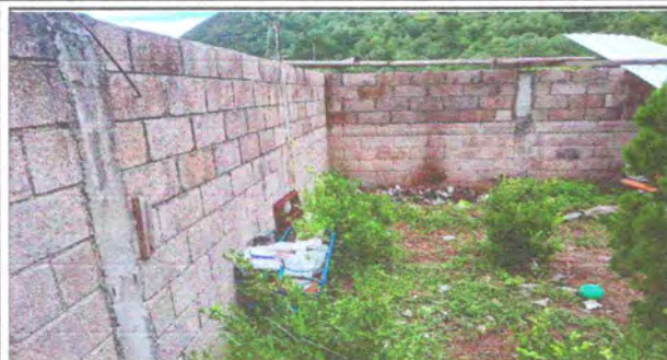
Foto7: Sustrucción de lamina troquelada aluzinc
