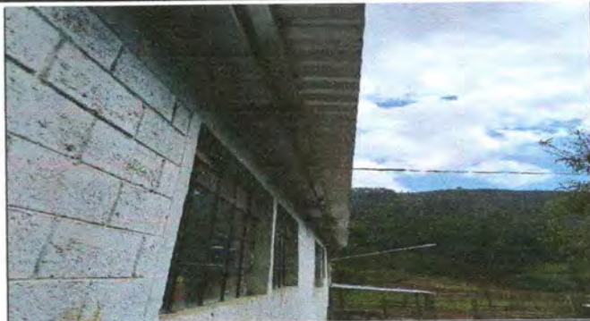
Foto 2: Sustrución de canal de metal
