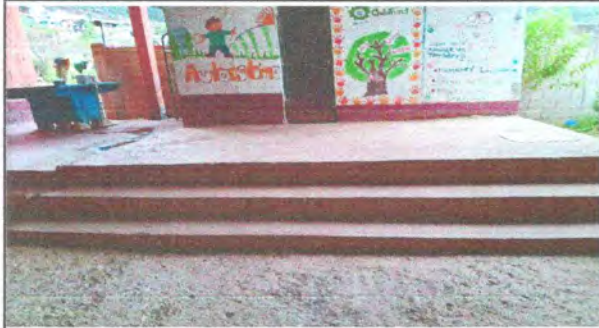
Foto 13: Reparación de piso del escenario
