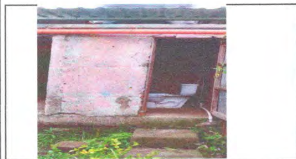
Foto11: Sustrucción de puerta de servicio sanitario
