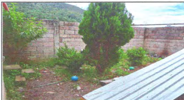
Foto 8: Mantenimiento a estructura de metal
