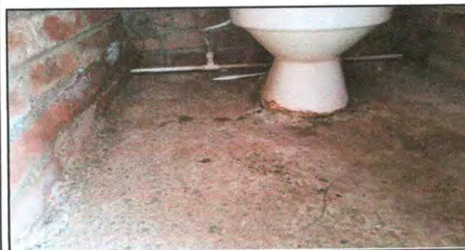
Foto 5: Sustrución de azulejo en baños
