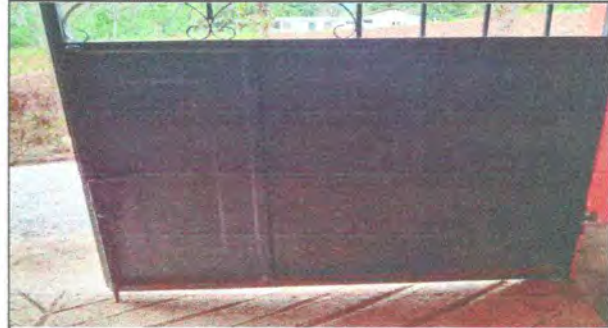
Foto 14: Mantenimiento de porton de metal
