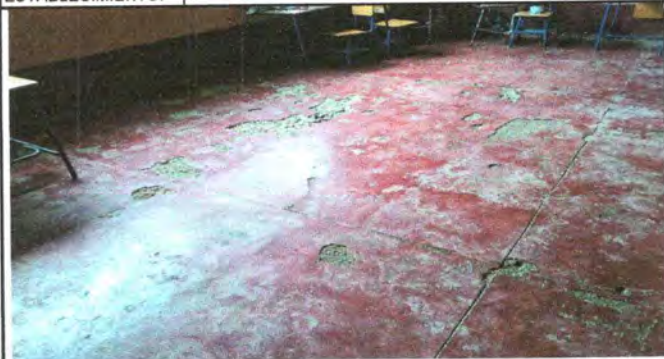
Foto 1: Sustrución de piso Granito en aulas
