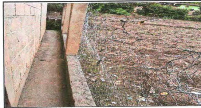
Foto 6: Sustrución de muro perimetral malla
