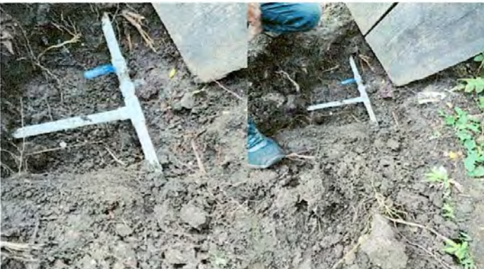
FOTO 9: Sustrucción de llaves de distribución de agua
