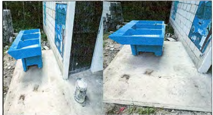
FOTO 10: Sustrucción de pila de cemento de dos lavaderos
