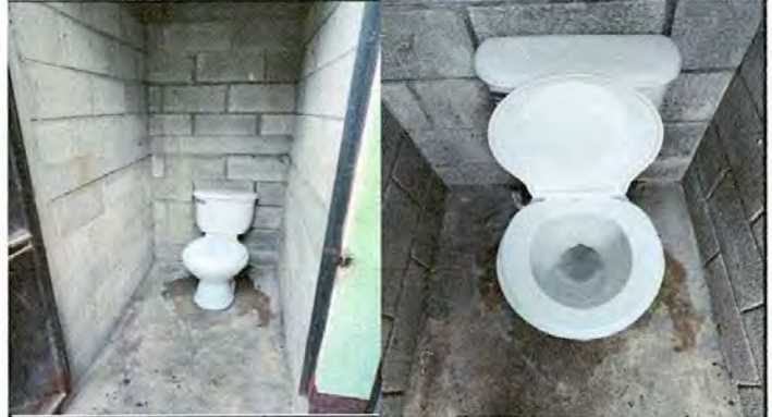
FOTO 8: Sustrucción de inodoros
