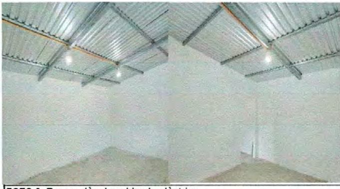
FOTO 6: Reparación de cableado eléctrico
