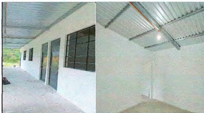
FOTO 3: Reparación y mantenimiento en paredes de aulas
