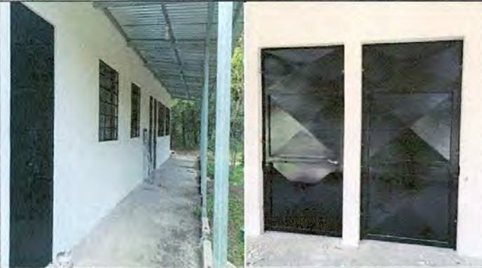
FOTO 7: Sustrucción de puertas de metal
