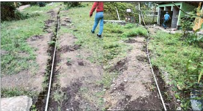
FOTO 11: Sustrucción de tubería de línea principal
