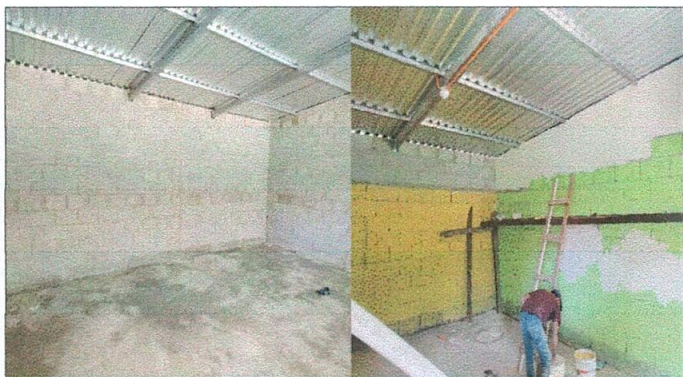
FOTO 3: Reparación y mantenimiento de paredes de 2 aulas
