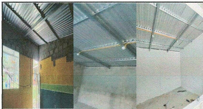
FOTO 5: Reparación de cableado eléctrico
