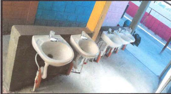
FOTO 7. SUSTITUCIÓN DE LAVAMANOS
