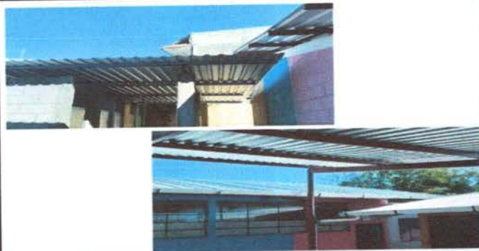
FOTO 1. CUBIERTA DE LÁMINA
