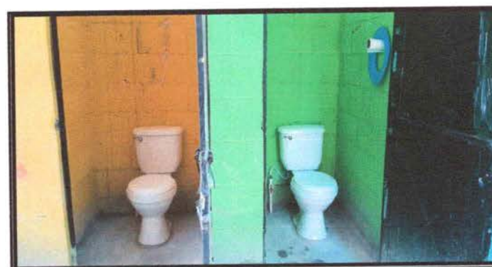
FOTO 6. SUSTITUCIÓN DE SANITARIOS
