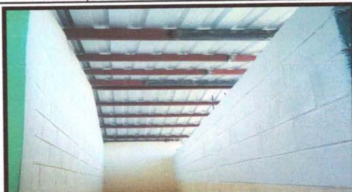
FOTO 2. MEJORAMIENTO DE ESTRUCTURA DE SOPORTE DE METAL
