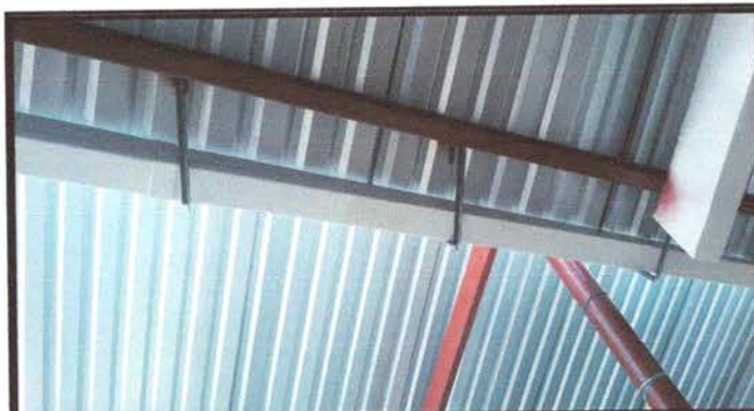
FOTO 4. SUSTITUCIÓN DE CANAL DE PVC
