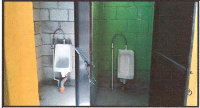
FOTO 8. SUSTITUCIÓN DE MINGITORIOS
