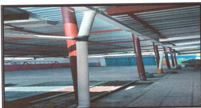
FOTO 5. MEJORAMIENTO DE BAJADAS DE AGUA PLUVIAL
