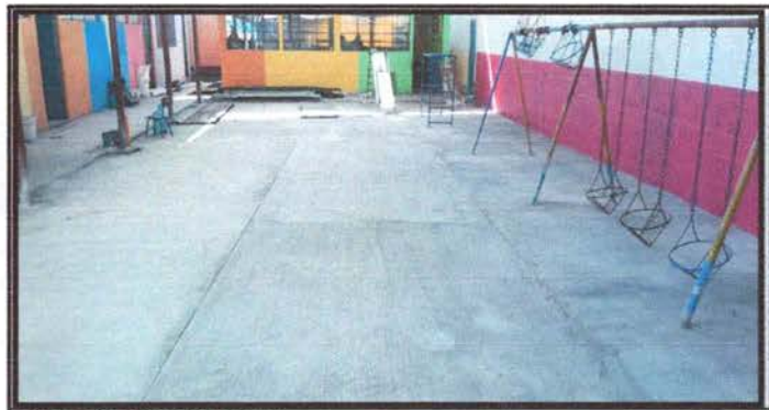
FOTO 12. LOSA DE PATIO
