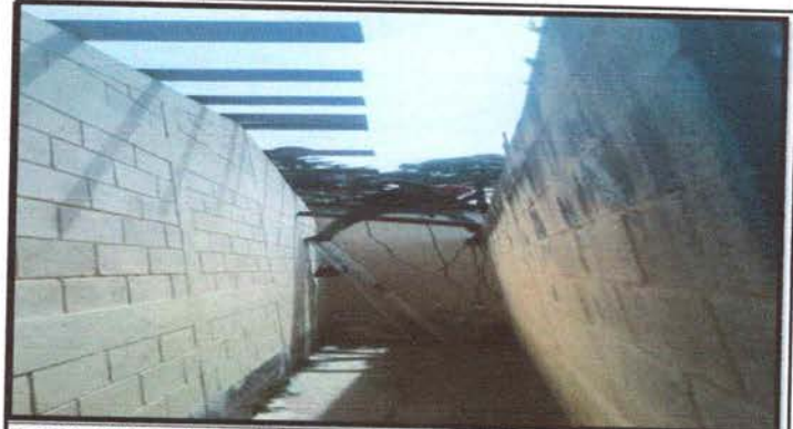
Foto 2: Mejoramiento de estructura de soporte de metal
