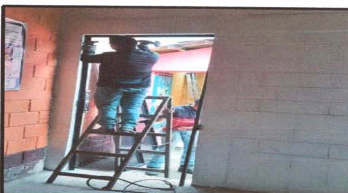
Foto 10. Mejoramiento de puerta de metal de aula
