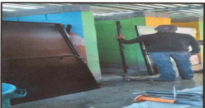
Foto 11. Mejoramiento de puerta de metal de baño
