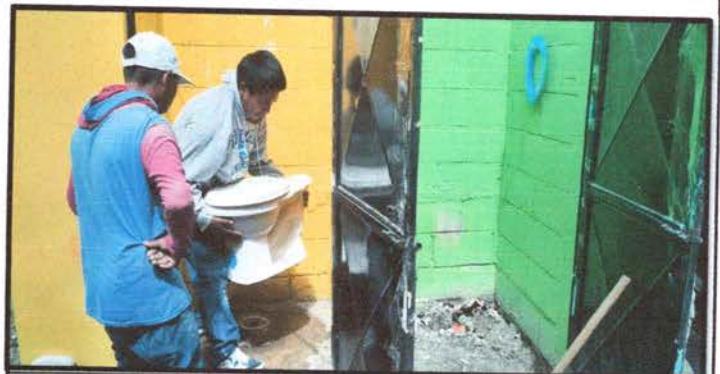
Foto 6: Sustitución y mejoramiento de inodoros
