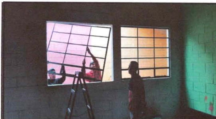
Foto 9. Mejoramiento de Ventanas de metal
