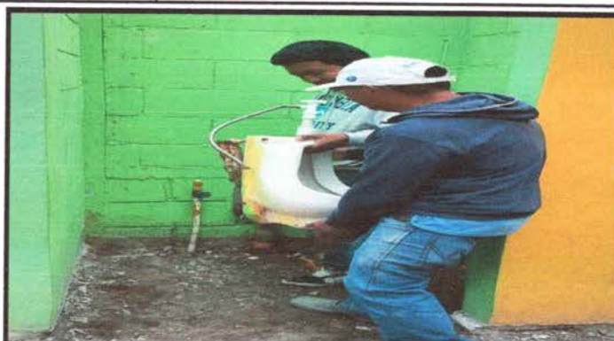
Foto 8 Sustitución de Mingitorio
