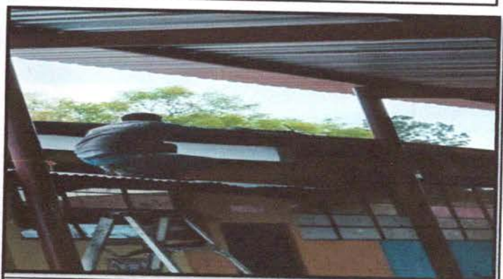
Foto 4: Sustitución de canal de pvc
