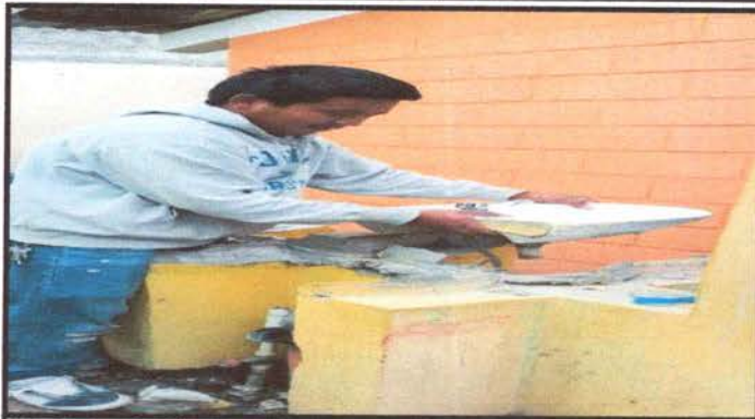
Foto7: Sustitución de lavamanos
