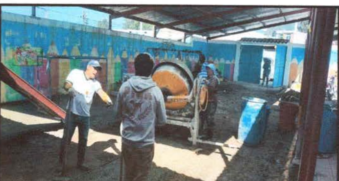
Foto 12 Reparación de plancha de concreto de patio.
