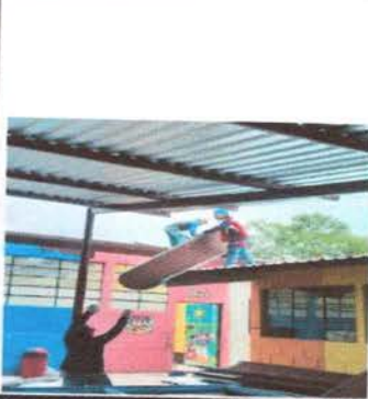
Foto1: Cubierta de lámina
