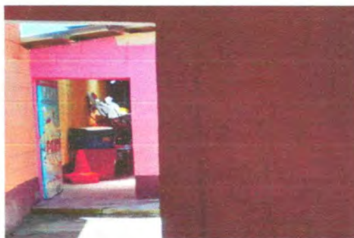
Foto 10. Mejoramiento de puerta de metal de aula
