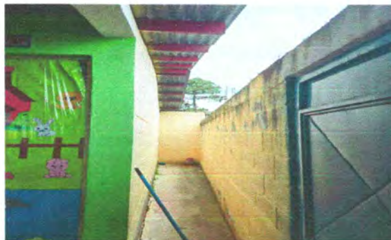
Foto 2: Mejoramiento de estructura de soporte de metal.
