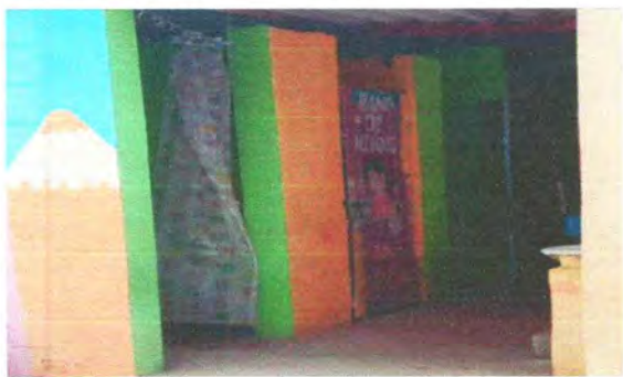
Foto 11. Mejoramiento de puerta de metal de baño
