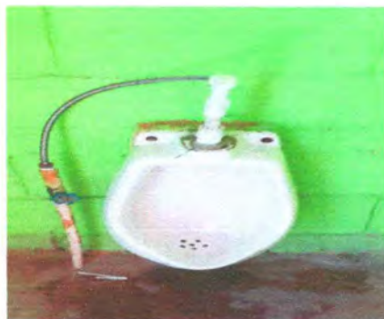
Foto 8 Sustitución de Mingitorio
