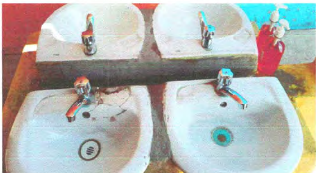
Foto7: Sustitución de lavamanos
