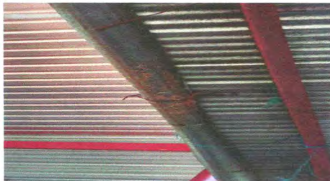
Foto 4: Sustitución de canal de PVC
