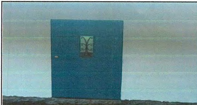
Foto 2: Mejoramiento de puerta de metal de 2 metros de alto por 1 metro de ancho
