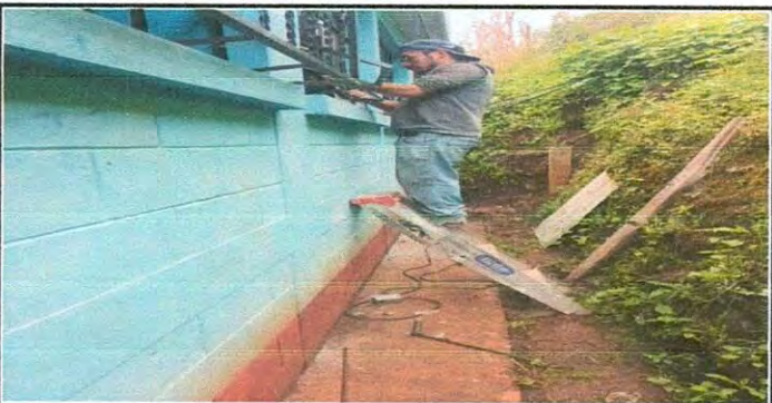
Foto 5: Sustrucción de balcones de metal de 1.8 metros de alto por 1.6 metros de ancho
