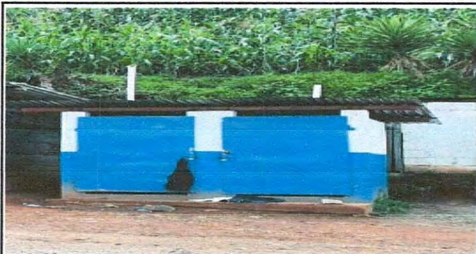
Foto 1: Sustrucción de puertas de madera por puertas de metal de 1.8 metros de alto por 0.90 metros de ancho
