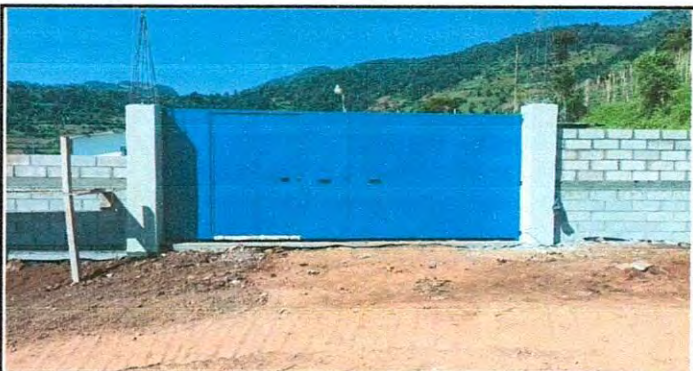
Foto 3: Sustrucción de porton de madera por metal de 5 metros de ancho por 2.5 metros de alto
