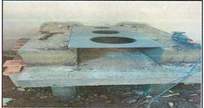
Foto 20: Sustitución de plancha de metal de 3 hornillas
