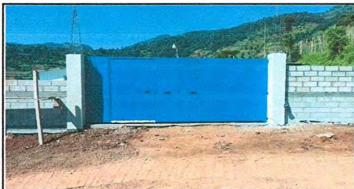
Foto 3: Sustrucción de porton de madera por metal de 5 metros de ancho por 2.5 metros de alto
