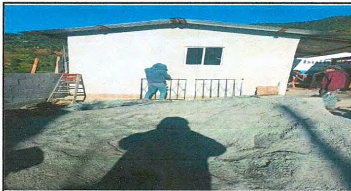
Foto 21: Repello de las paredes de block de la cocina.
