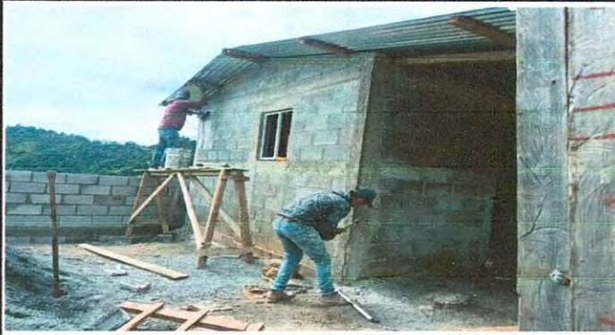
Foto 19: Mano de obra en albañilería
