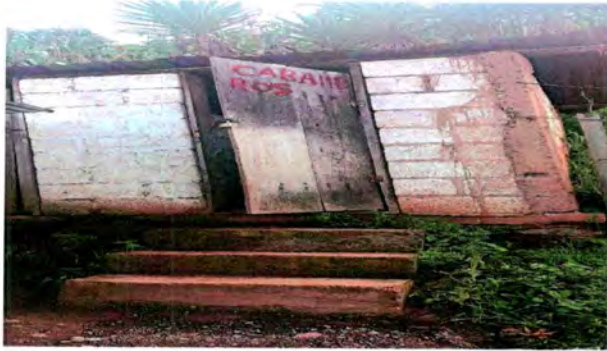
Foto1: Sustrucción de puertas de madera por puertas de metal de 1.8 metros de alto por 0.90 metros de ancho.
