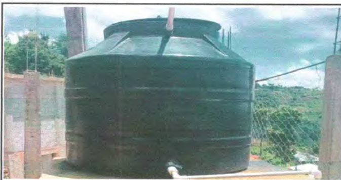
Foto 17: Sustitución de deposito de agua 2,500 lt
