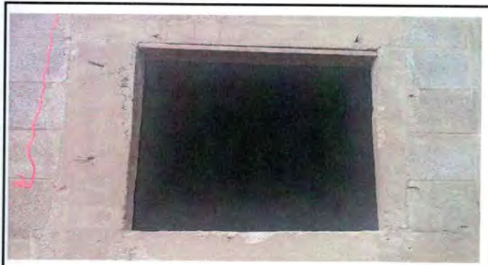
Foto 4: Mejoramiento de ventanas de 0.80 metros de alto por 0.70 metros de ancho.
