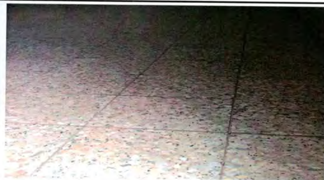
Foto 8: Instalación de piso de granito
