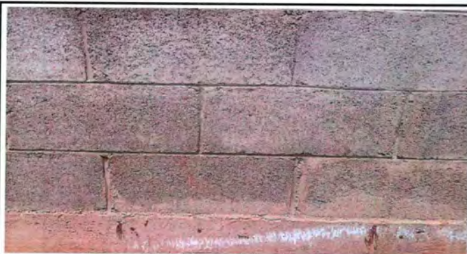
Foto 9: Pintura en muros exteriores e interiores
