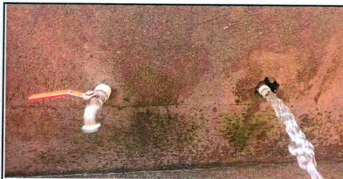
Foto 12: Sustitución de grifos
