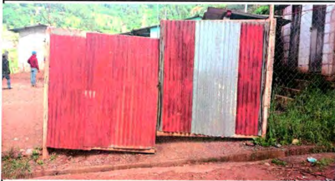
Foto 3: Sustrucción de portón de madera por metal de 5 metros de ancho por 2.5 metros de alto.
