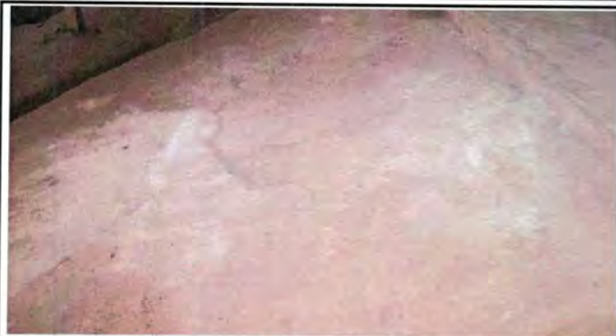
Foto 7: Sustitución de piso de torta de concreto.
