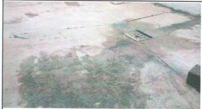
Foto 16: Reparación de planchas de concreto de patio
