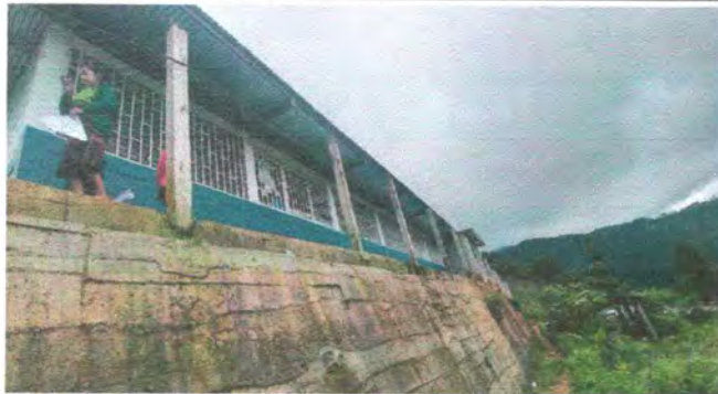
Foto 15: Sustitución de 5 hileras de muro perimetral de block, con soleras intermedias, malla galvanizada y tubos hg.
