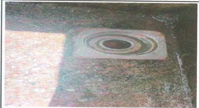
Foto 14: Sustitución de reposadera
