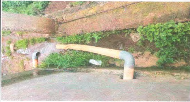
Foto 13: Sustitución de tubería PVC línea principal aguas negras
