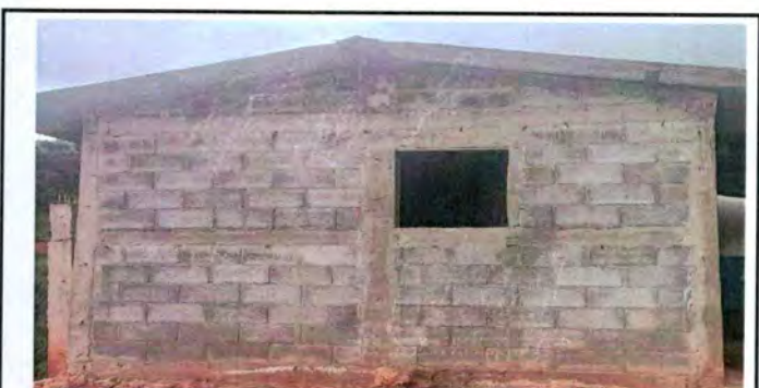
Foto 6: Mejoramiento de balcones de metal de 0.80 metros de alto por 0.70 metros de ancho.
