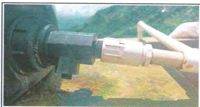
Foto 18: Sustitución de accesorios deposito de agua
