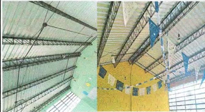
FOTO 1: Sustrucción de estructura de soporte de metal por metal
