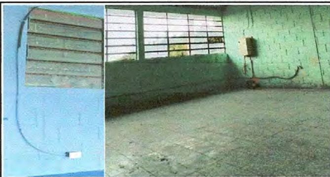
FOTO 5: Reparación del cableado eléctrico y accesorios
