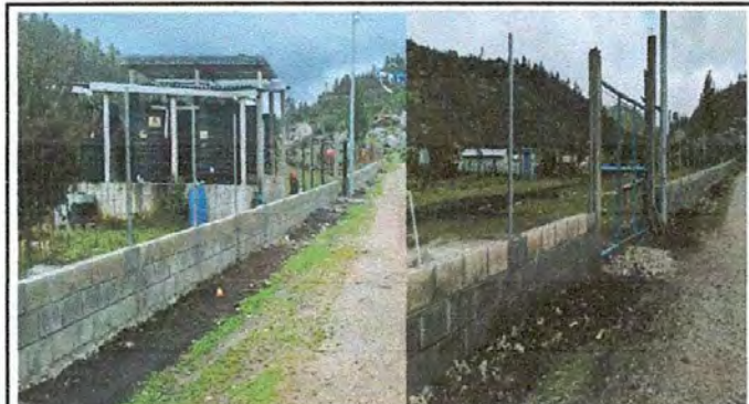
FOTO 4: Sustrucción de muro perimetral de y malla por block con tubo hg y malla galvanizada
