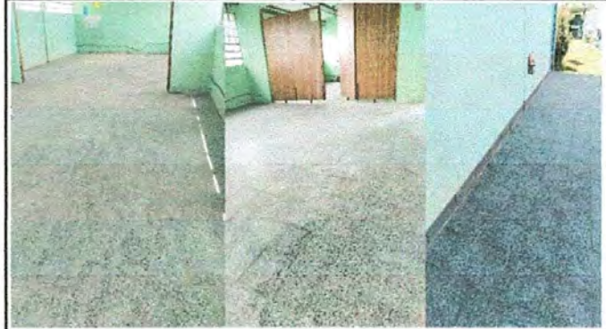
FOTO 2: Sustrucción de piso de torta de cemento por piso de granito
