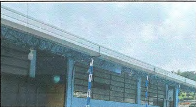
FOTO 3: Sustrucción de canal de metal por metal
