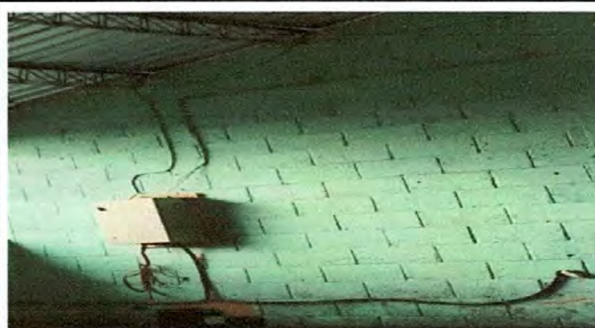
FOTO 8: Sustitución de tablero Monofásico
