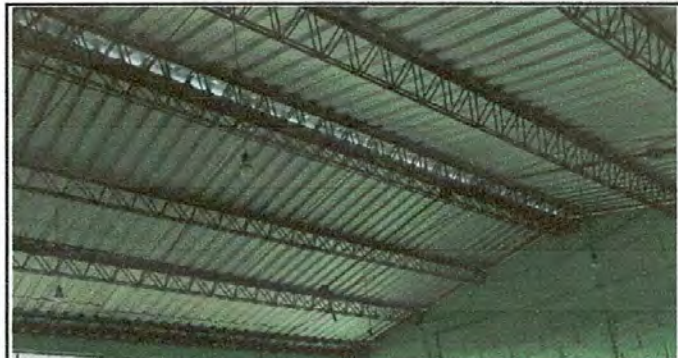
FOTO 6: Sustrucción de plafoneras Y lamparas LED
