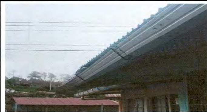
FOTO 3: Sustrucción de canal de metal por metal
