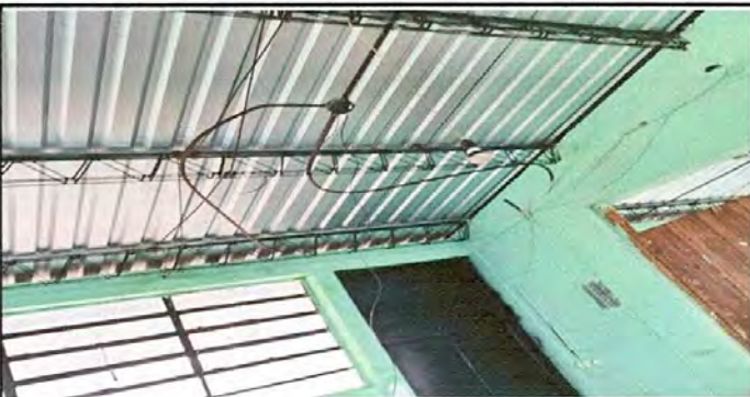
FOTO 5: Reparación del cableado eléctrico y accesorios
