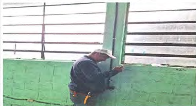
FOTO 7: Sustitución de caja octagonal
