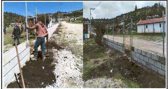
FOTO 4: Sustrucción de muro perimetral de y malla por block con tubo hg y malla galvanizada
