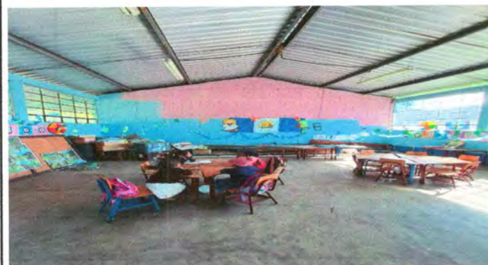
Foto 3: Pintura en interiores y exteriores
