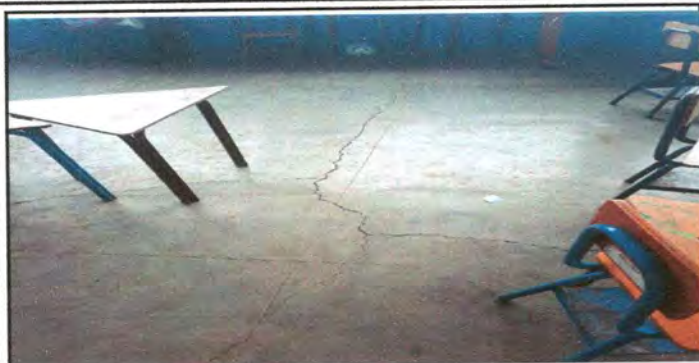
Foto 1: Sustrucción de piso de aulas
