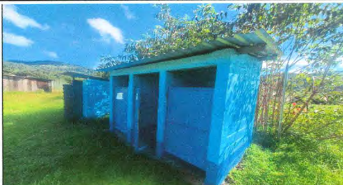
Foto 2: Mantenimiento a puertas en sanitarios
