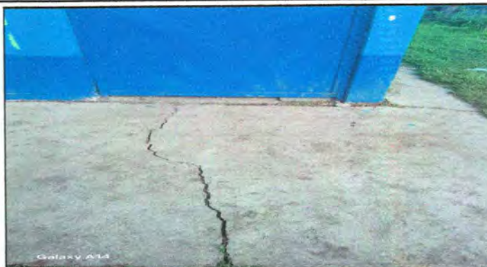
Foto 2: Reparación de piso de torta de concreto
