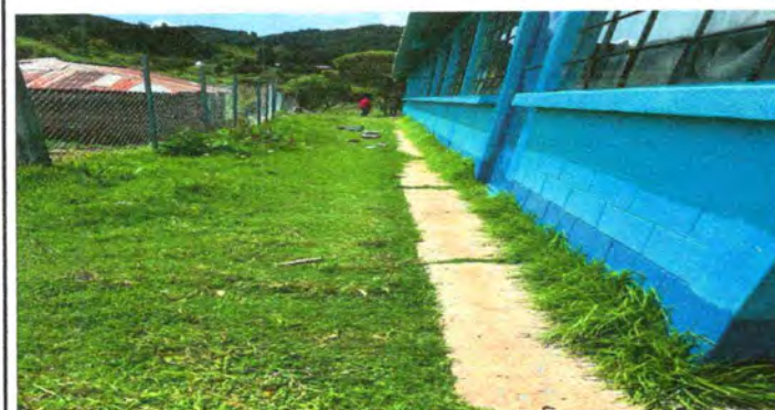
Foto 5: Mejoramiento en torta de concreto
