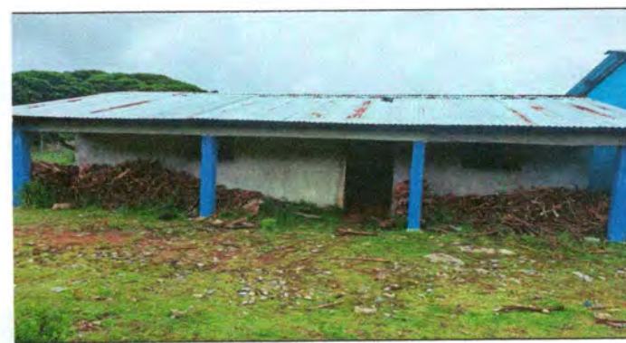
Foto 6: Cubierta de lámina
