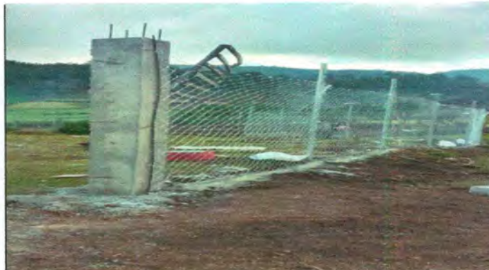
Foto 4: Mejoramiento Muro Perimetral (3 hiladas de block)
