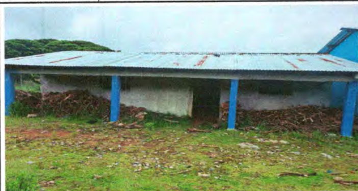
Foto1: Estructura de en área de cocina
