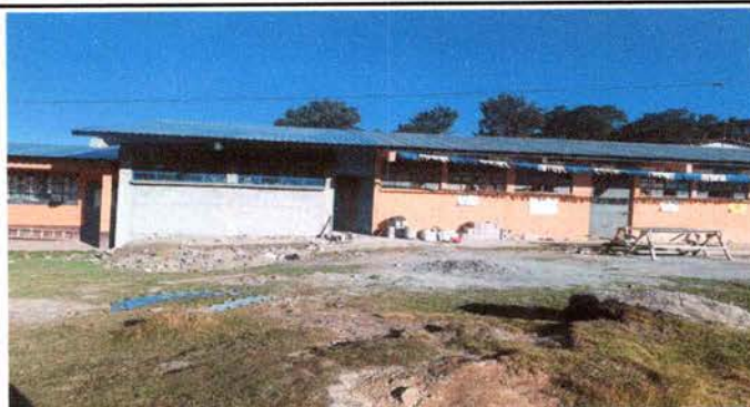
Foto 2: Reparación y ampliación de cocina.
