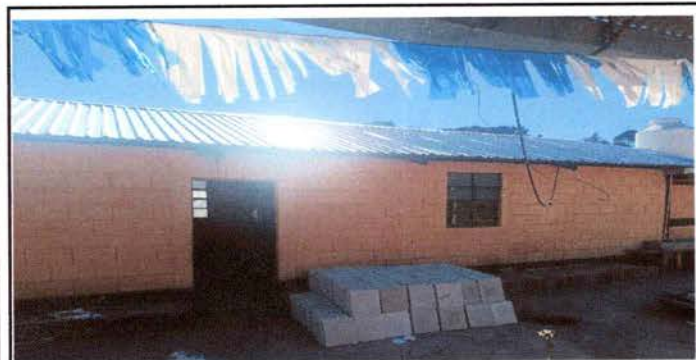
Foto 5: Sustitución de lamina en mal estado por lamina troquelada en aula del modulo uno del Establecimiento.
