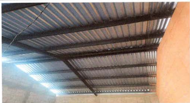
Foto1: Sustitución y construcción de cocina y cambio de techo.
