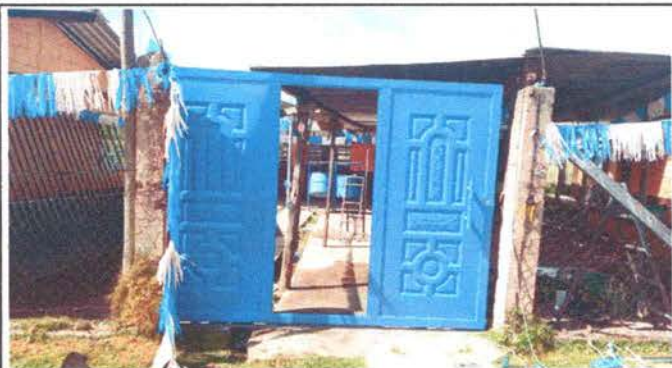
Sustitución de porton
