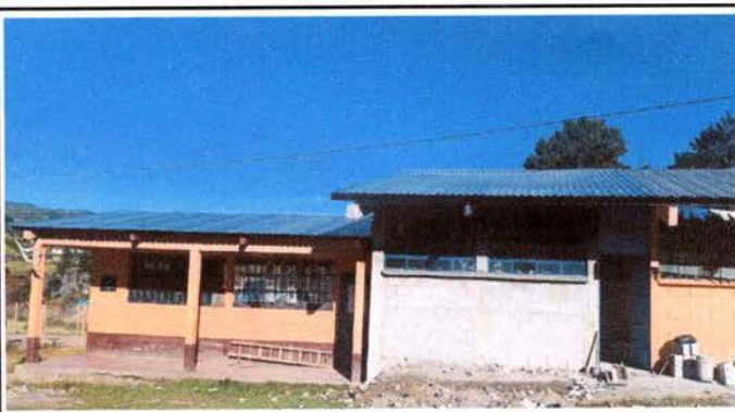
Foto 4: Sustitución de lamina en mal estado por lamina troquelada en aula del modulo dos del Establecimiento.
