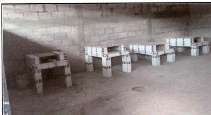
Foto 3: Sustitución de estufa rural por plancha de metal en cocina nueva.
