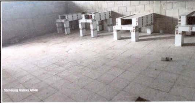
Foto 6: Sustitución de piso de torta de cemento por piso de granito en cocina.
