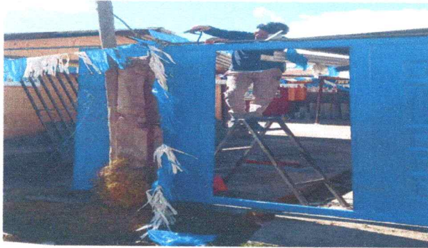
Sustitución de porton
