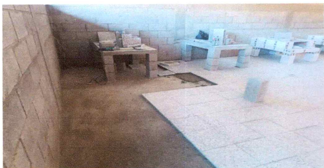
Foto 3: Sustrucción de estufa rural por plancha de metal en cocina nueva.
