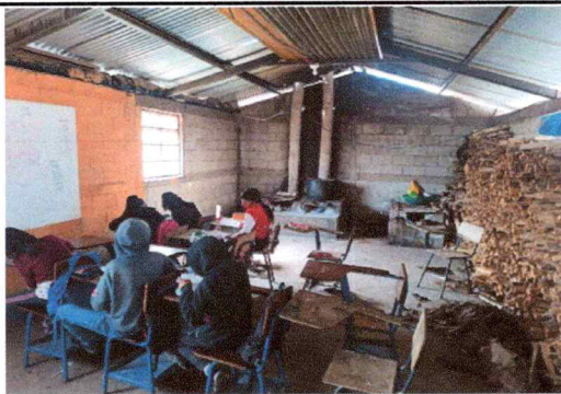
Foto 5: Sustrucción de lamina en mal estado por lamina troquelada en aula del modulo uno del Establecimiento.
