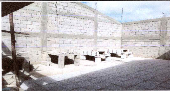
Foto1: Sustrucción y construcción de cocina y cambio de techo.
