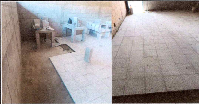
Foto 6: Sustrucción de piso de torta de cemento por piso de granito en cocina.
