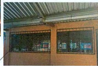
Foto 6: Mejoramiento de balcones para ventana
