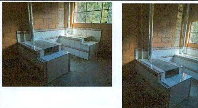
Foto 11: Sustrucción de estufa rural (completa) incluye chimenea y plancha de metal y mejoramiento de azulejo en estufa rural
