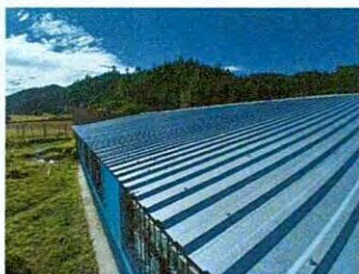
Foto1: Sustitución de lámina, por lámina troquelada aluzinc calibre 26 y Sustitución de capote por lámina troquelada
