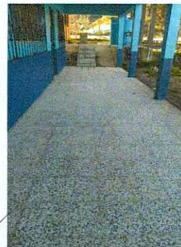
Foto 4: Sustitución de piso de torta de concreto
