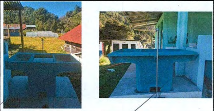
Foto 12: Sustrucción de Pila de dos lavaderos
