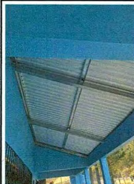
Foto 2: Sustitución de soporte de estructura de madera por metal
