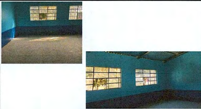
Foto 9: Repello en muro
