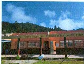
Foto 1: Sustrucción de lámina, por lámina troquelada aluzinc calibre 26 y Sustrucción de capote por lámina troquelada
