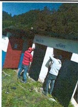
Foto 7: Sustitución de puertas en servicios sanitarios
