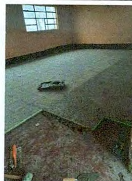
Foto 4: Sustrucción de piso de torta de concreto
