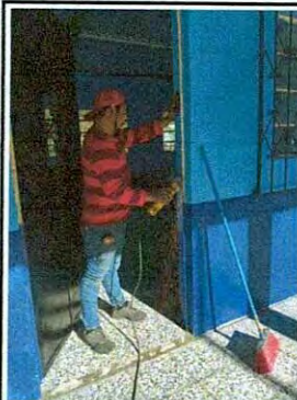
Foto 3: Mantenimiento a estructura de puerta y Sustrucción de chapa
