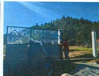
Foto 8: Sustitución de portón de metal de 2 metros por 3 metros
