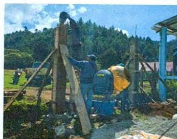
Foto 10: Sustitución estructura de soporte para portón
