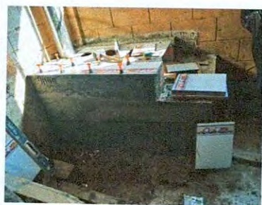
Foto 11: Sustitución de estufa rural (completa) incluye chimenea y plancha de metal y mejoramiento de azulejo en estufa rural
