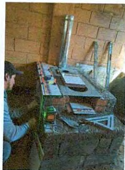
Foto 11: Sustitución de estufa rural (completa) incluye chimenea y plancha de metal y mejoramiento de azulejo en estufa rural
