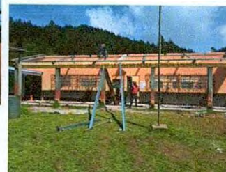
Foto 2: Sustrucción de soporte de estructura de madera por metal
