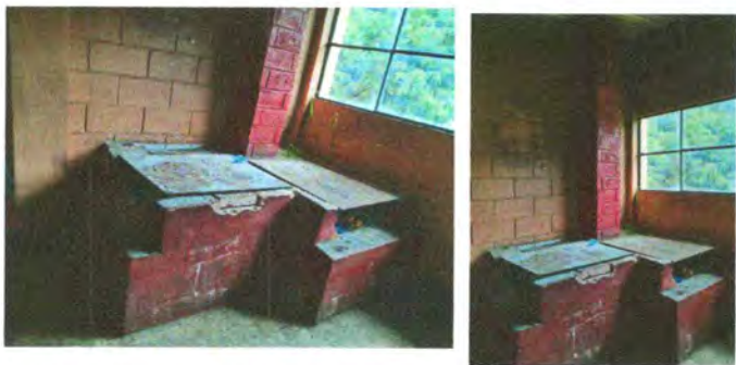
Foto 11: Sustrucción de estufa rural (completa) incluye chimenea y plancha de metal y mejoramiento de azulejo en estufa rural
