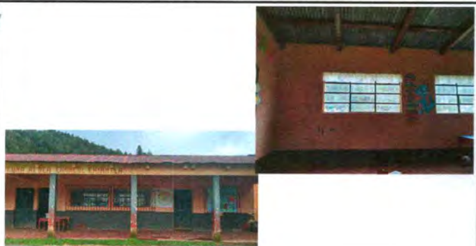
Foto 5: Pintura de exteriores e interiores
