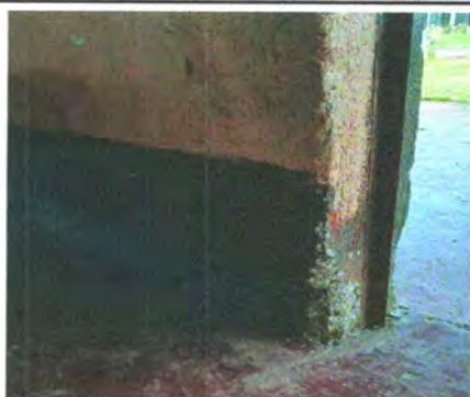
Foto 9: Repello en muro
