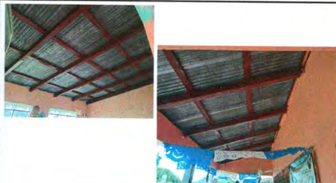
Foto 2: Sustitución de soporte de estructura de madera por metal
