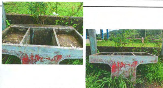
Foto 12: Sustrucción de Pila de dos lavaderos
