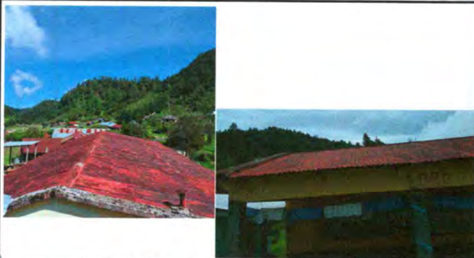
Foto1: Sustitución de lámina, por lámina troquelada aluzinc calibre 26 y Sustitución de capote por lámina troquelada
