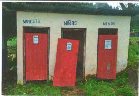
Foto 7: Sustrucción de puertas en servicios sanitarios
