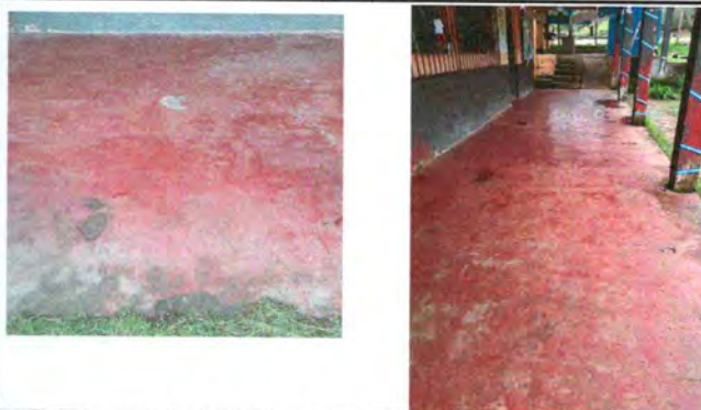
Foto 4: Sustitución de piso de torta de concreto
