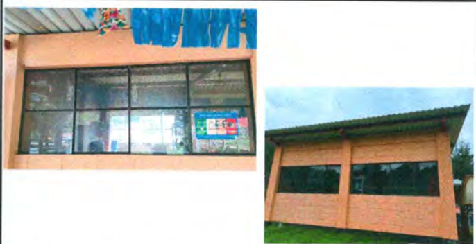
Foto 6: Mejoramiento de balcones para ventana
