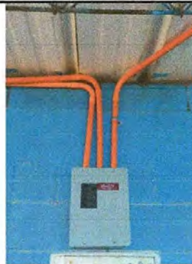
Foto 2: Sustrución de caja de flípones
