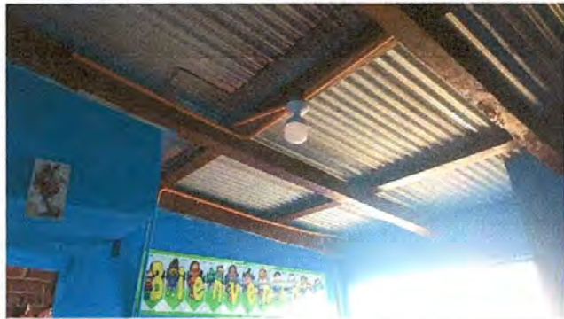
Foto 1: Sustrucción de flaponeras
