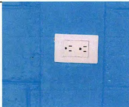
Foto 5: Sustrución de tomacorrientes
