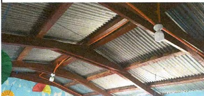
Foto 3: Sustrución de cableado electrico
