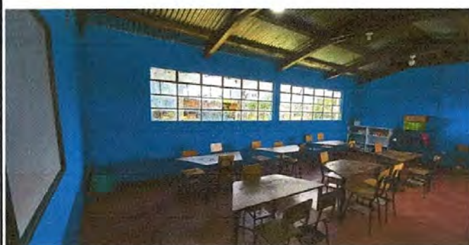
Foto 2: Pintura de interiores
