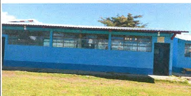
Foto 4: Sustrución de estructura de techo y lamina
