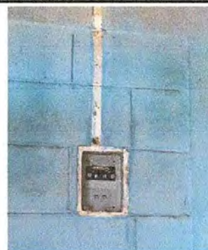
Foto 2: Sustrución de caja de flípones
