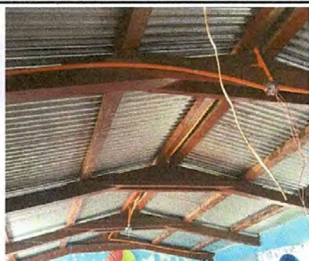
Foto 3: Sustrución de cableado electrico
