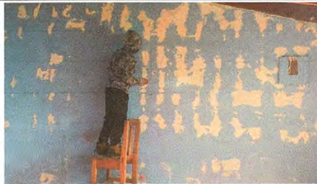
Foto 8: Pintura de interiores
