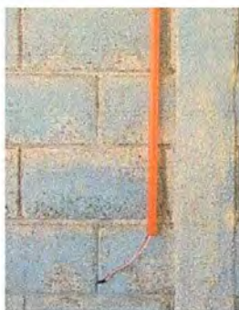
Foto 5: Sustrución de tomacorrientes
