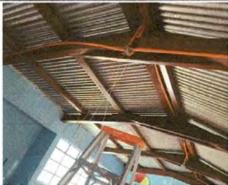
Foto 7: Sustitucion de flaponeras
