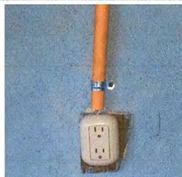
Foto 6: Sustrución de interruptores
