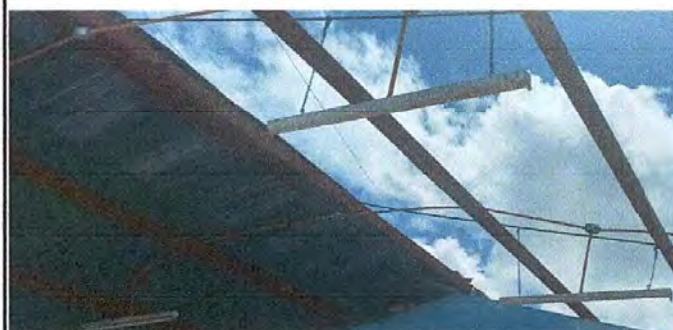
Foto 4: Sustrución de estructura de techo y lamina
