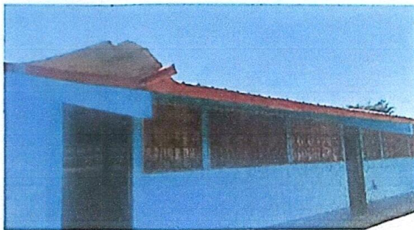
Foto 1. Sustitución de lamina por lamina
