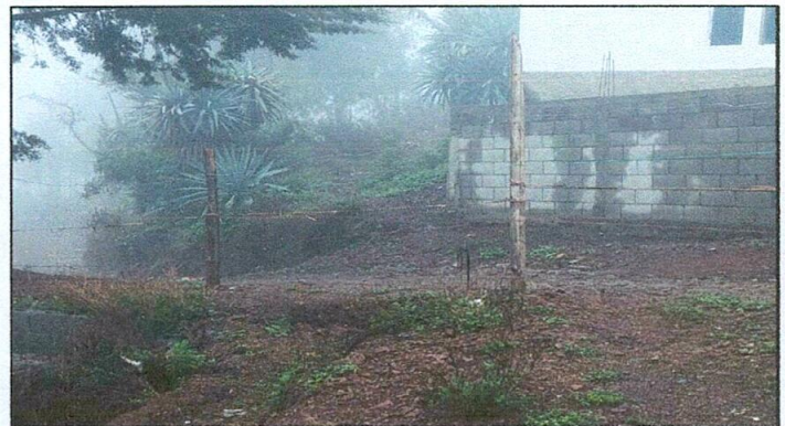
Foto 10: reparación de muro perimetral
