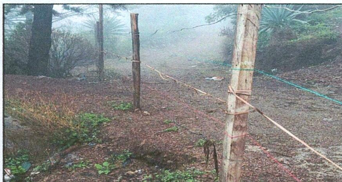
Foto 11: reparación de muro perimetral
