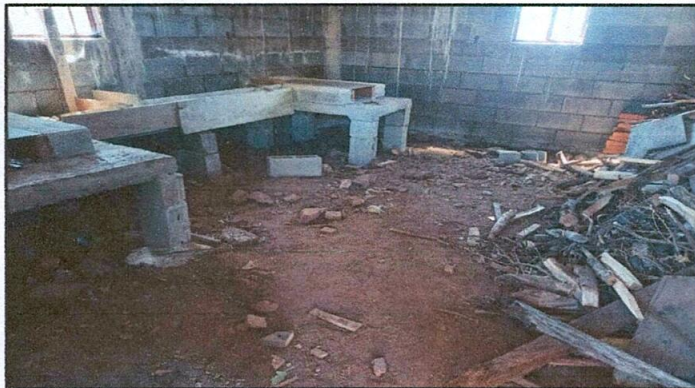
Foto 7: Mantenimiento a estufa rural
