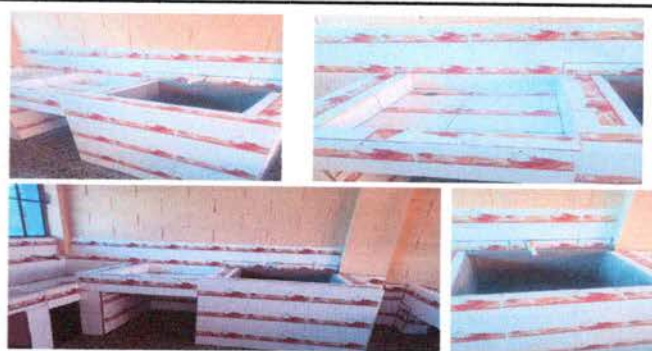
Foto 12: SUSUTITUCIÓN DE PILA PLÁSTICA DE UN LAVADERO POR LAVATRASTOS DE CONCRETO
