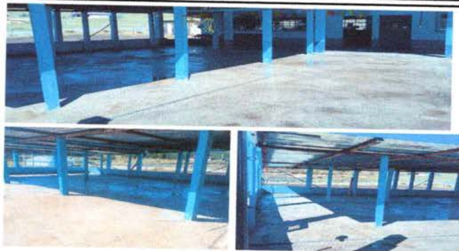
Foto 13: SUSTITUCIÓN DE LOSA DE CONCRETO POR LOSA DE CONCRETO DE PATIO
