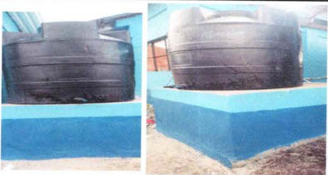
Foto 9: SUSTITUCIÓN DE DEPOSITO DE AGUA 2,500 LTS
