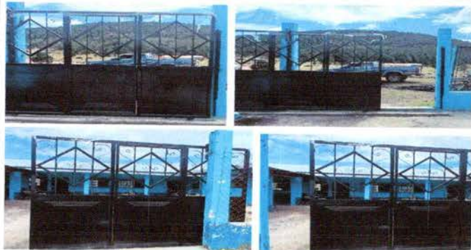
Foto1: SUSTITUCIÓN DE PORTÓN DE METAL
