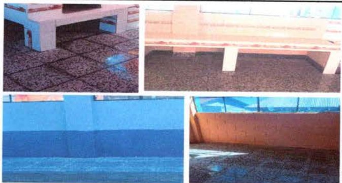
Foto 3: SUSTITUCIÓN DE PISO DE TORTA DE CONCRETO POR GRANITO
