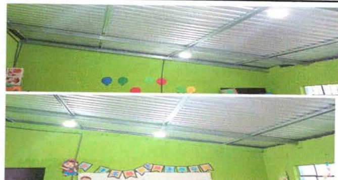
Foto 8: REPARACIÓN DE SISTEMA ELÉCTRICO
