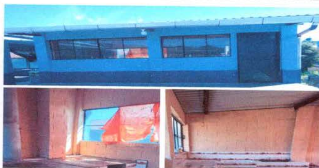
Foto 4: PINTURA EN MUROS EXTERNOS E INTERNOS
