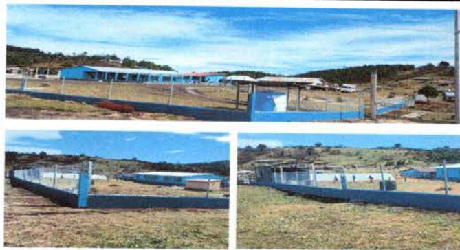
Foto 7: REPARACIÓN DE MURO PERIMETRAL DE BLOCK
