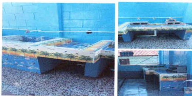
Foto 6: REPARACIÓN DE LAVAMANOS MULTIFUNCIONAL DE CONCRETO Y AZULEJO
