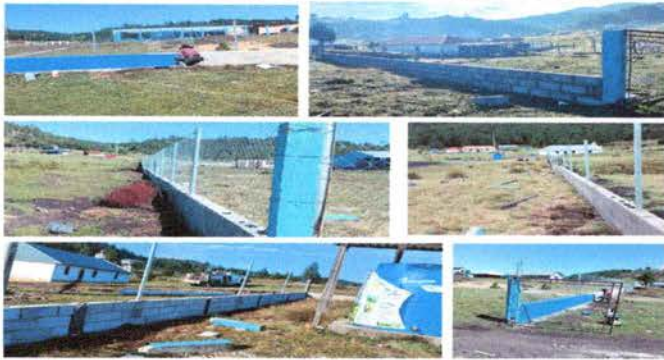
Foto 7: REPARACIÓN DE MURO PERIMETRAL DE BLOCK
