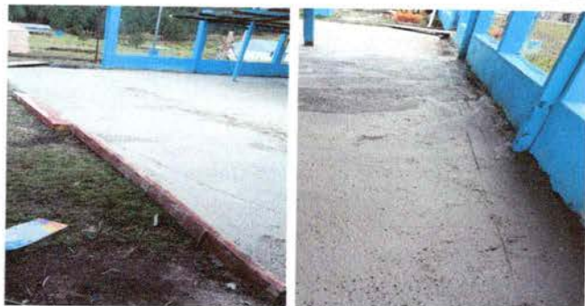
Foto 13: SUSTITUCIÓN DE LOSA DE CONCRETO POR LOSA DE CONCRETO DE PATIO
