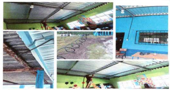
Foto 8: REPARACIÓN DE SISTEMA ELÉCTRICO
