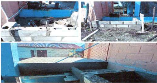
Foto 9: SUSTITUCIÓN DE DEPOSITO DE AGUA 2,500 LTS
