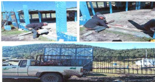
Foto1: SUSTITUCIÓN DE PORTÓN DE METAL
