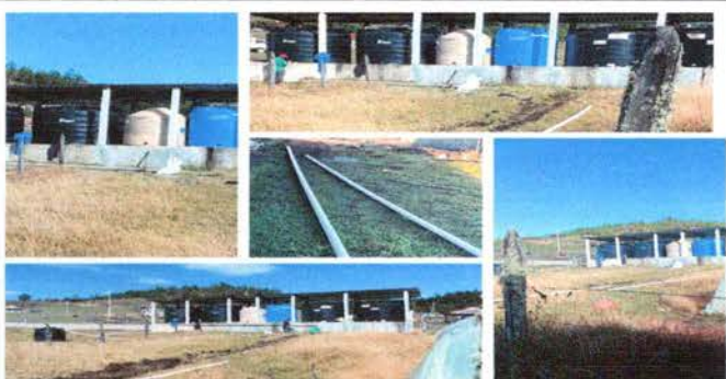
Foto 5: REPARACIÓN DE RED DE AGUAS PLUVIALES
