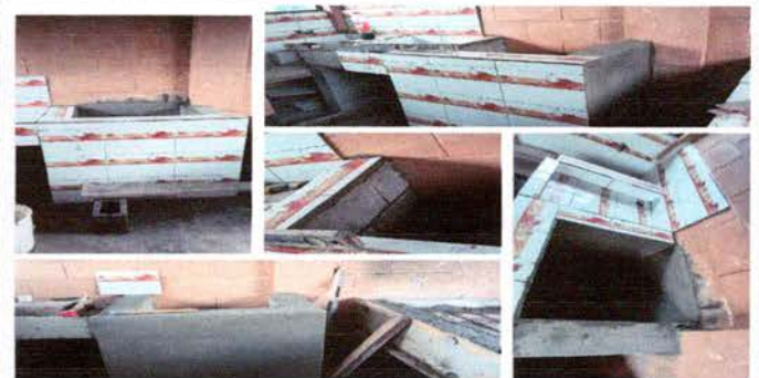
Foto 12: SUSUTITUCIÓN DE PILA PLÁSTICA DE UN LAVADERO POR LAVATRASTOS DE CONCRETO
