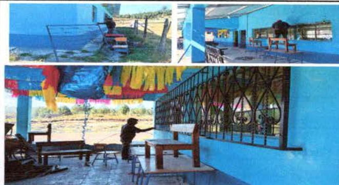
Foto 2: MEJORAMIENTO DE BALCONES A METAL
