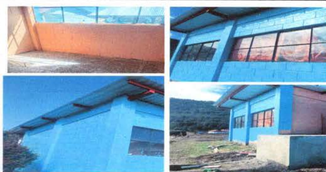
Foto 4: PINTURA EN MUROS EXTERNOS E INTERNOS
