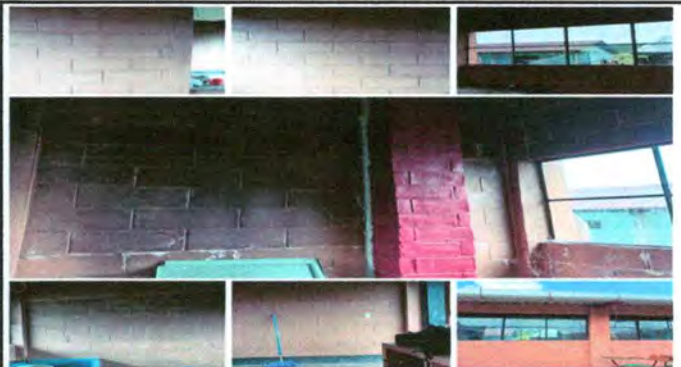
Foto 4: PINTURA EN MUROS EXTERNOS E INTERNOS
