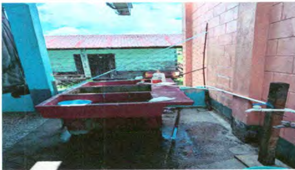
Foto 9: SUSTITUCIÓN DE DEPOSITO DE AGUA 2,500 LTS
