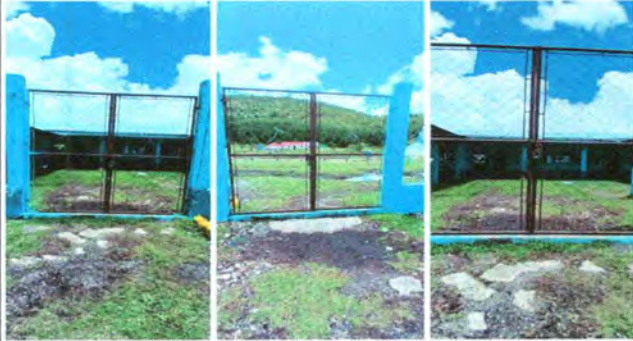
Foto1: SUSTITUCIÓN DE PORTÓN DE METAL
