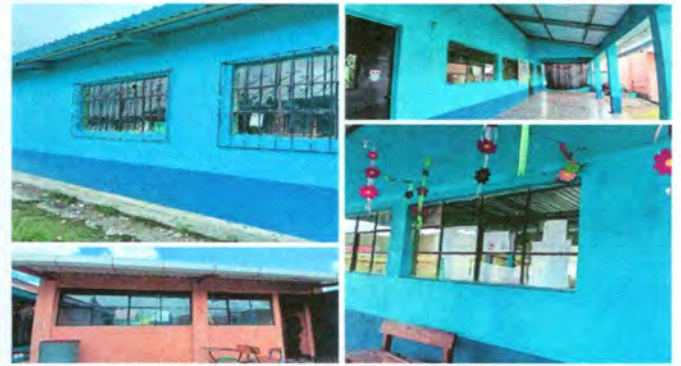
Foto 2: MEJORAMIENTO DE BALCONES A METAL
