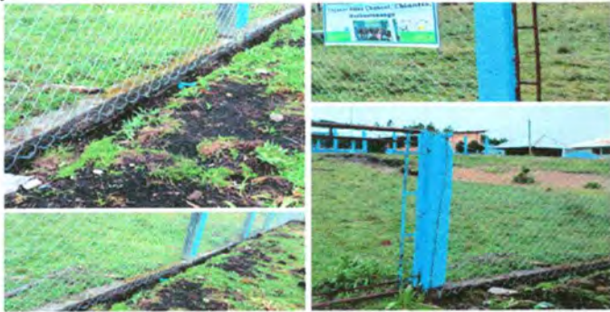
Foto 7: REPARACIÓN DE MURO PERIMETRAL DE BLOCK
