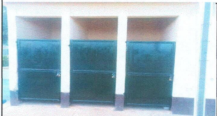
Foto 3: Mantenimiento en puertas
