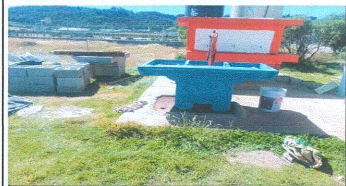
Foto 5: Sustitución de pila de concreto
