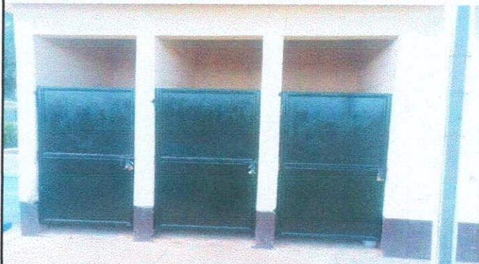
Foto 3: Mantenimiento en puertas
