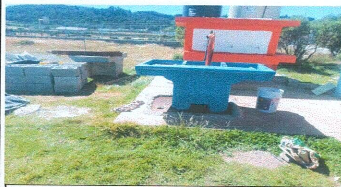
Foto 5: Sustitución de pila de concreto
