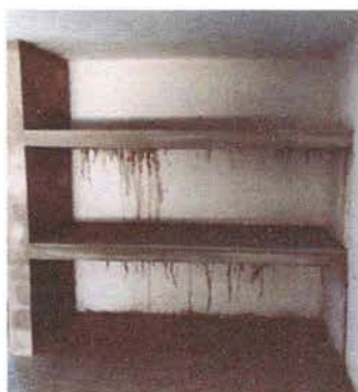
Foto 15: Sustitución de mueble de de madera por mueble de concreto en bodega de cocina
