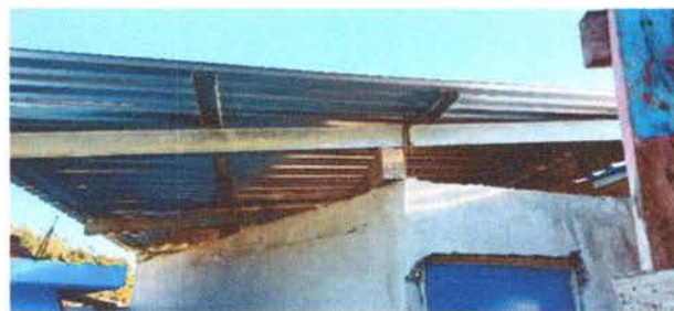
Foto 18: Sustitución de estructura de soporte de madera, por metal
