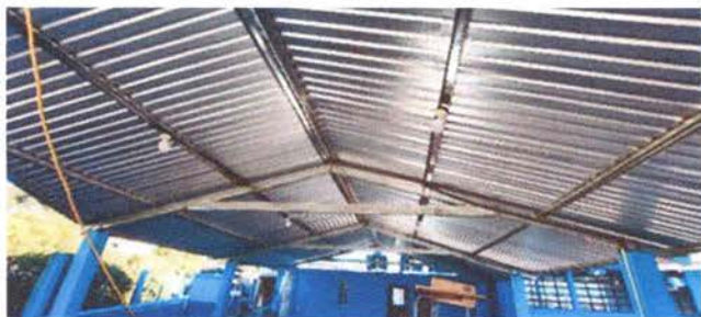
Foto 13: Sustitución de ducto eléctrico mas accesorios
