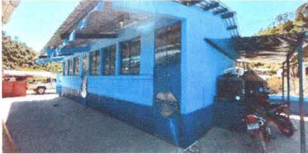
Foto 7: Pintura en muros exteriores
