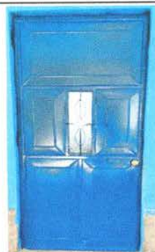
Foto 4: Sustrucción puerta de cocina
