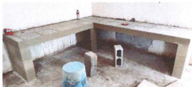
Foto 14: Sustitución de mueble de madera por mueble de concreto en cocina
