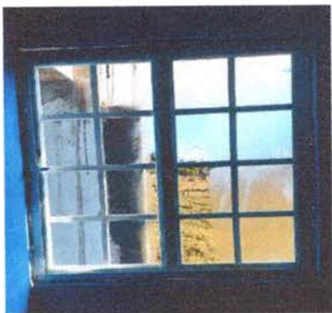
Foto 1: Sustrucción de estructura de metal de ventanas
