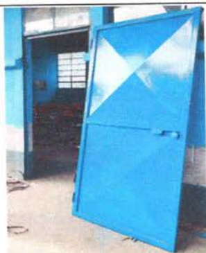
Foto 3: Sustitución puerta de aula
