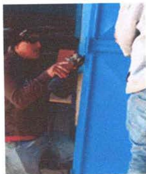
Foto 5: Sustitución puerta de bodega de cocina
