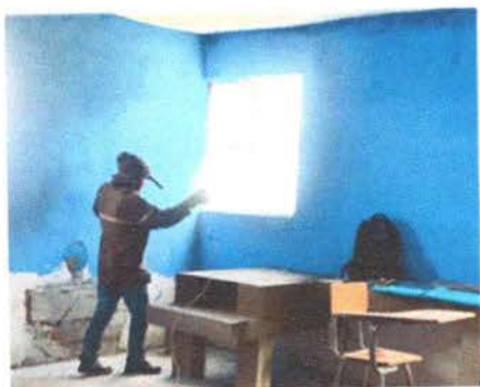
Foto 1: Sustitución de estructura de metal de ventanas
