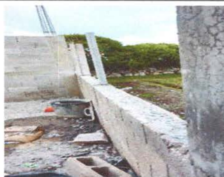
Foto 16: Ampliación de muro en bodega de cocina.
