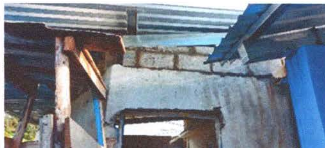
Foto 18: Sustitución de estructura de soporte de madera, por metal
