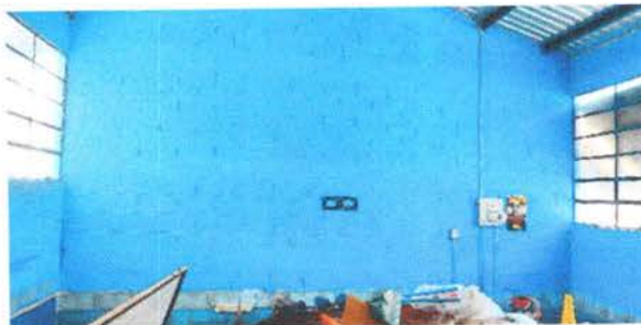
Foto 8: Pintura en muros interiores
