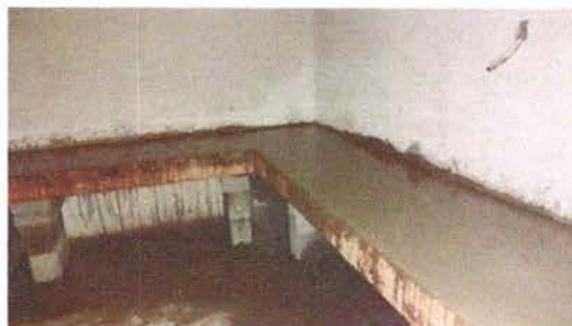
Foto 14: Sustitución de mueble de madera por mueble de concreto en cocina
