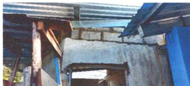
Foto 17: Sustitución de lámina, por lámina troquelada aluzinc calibre 26
