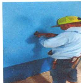
Foto 12: Reparación de cableado eléctrico
