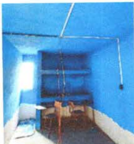
Foto 11: Sustitución de plafoneras
