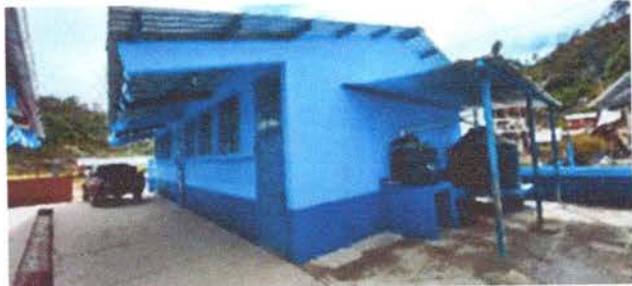
Foto 7: Pintura en muros exteriores
