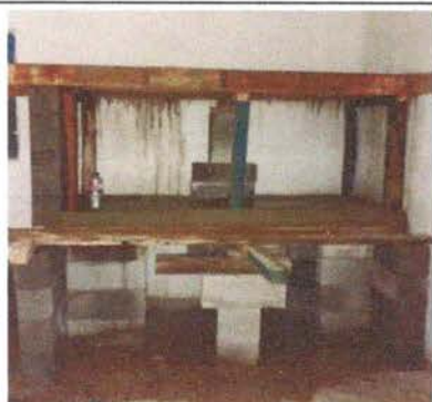
Foto 15: Sustitución de mueble de de madera por mueble de concreto en bodega de cocina
