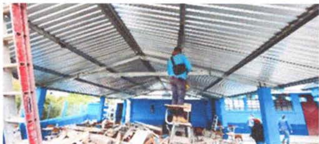
Foto 13: Sustitución de ducto eléctrico mas accesorios
