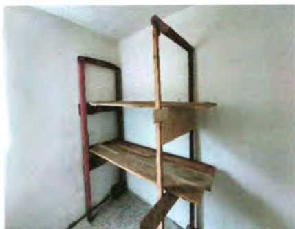
Foto 15: Sustrucción de mueble de de madera por mueble de concreto en bodega de cocina
