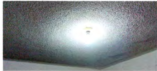
Foto 10: Sustitución de focos ahorradores
