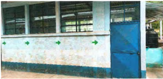
Foto 7: Pintura en muros exteriores
