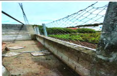
Foto 16: Ampliación de muro en bodega de cocina.
