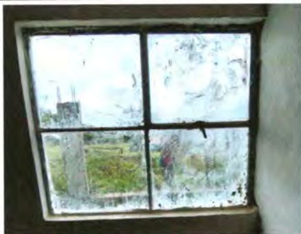
Foto 1: Sustrucción de estructura de metal de ventanas
