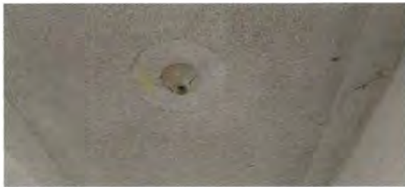
Foto 11: Sustitución de plafoneras
