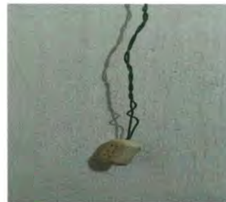
Foto 12: Reparación de cableado eléctrico
