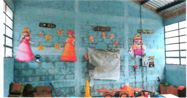
Foto 8: Pintura en muros interiores
