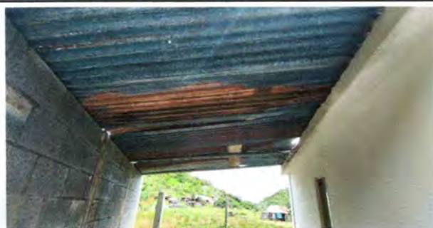
Foto 18: Sustrucción de estructura de soporte de madera, por metal
