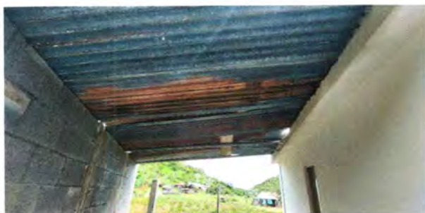
Foto 17: Sustrucción de lámina, por lámina troquelada aluzinc calibre 26
