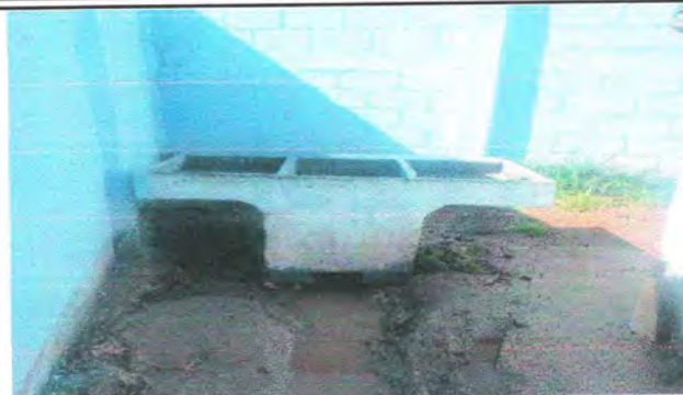
FOTO 2: SUSTITUCION DE PILA DE CONCRETO
