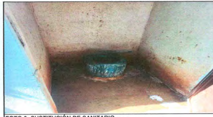
FOTO 6: SUSTITUCIÓN DE SANITARIO
