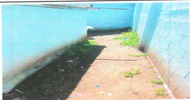
FOTO 4: COLOCACION DE CANAL PARA CAPTACION DE AGUA DE LLUVIA
