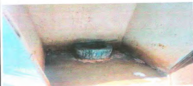
FOTO 1: OLOCACION DE AZULEJO EN SANITARIOS
