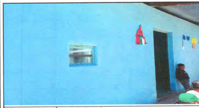
FOTO 5: AMPLIACIÓN DE VENTANAS
