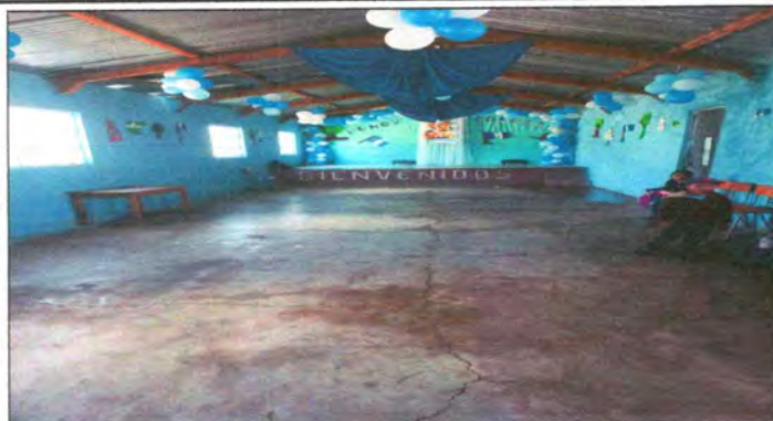
FOTO 1: SUSTITUCIÓN DE TORTA POR PISO GRANITO
