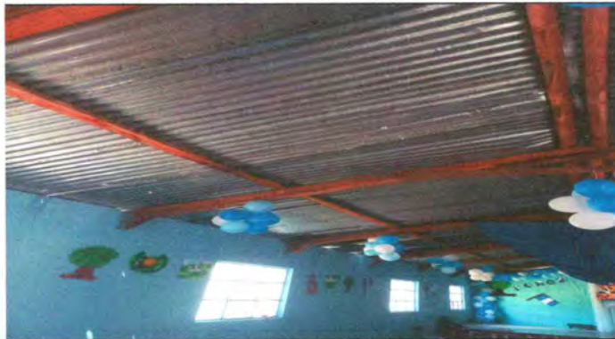
FOTO 2: SUSTITUCIÓN DE ESTRUCTURA DE MADERA POR METAL
