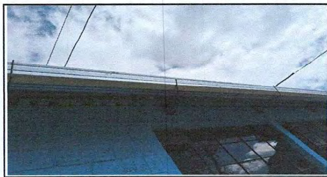
Foto 6: Instalación de canales de metal.
