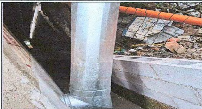
Foto13: Colocación de chimenea de metal en cocina.
