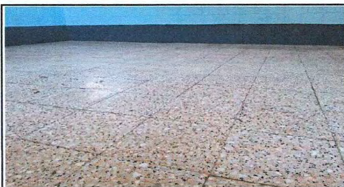
Foto 9: Colocación de granito en aula.
