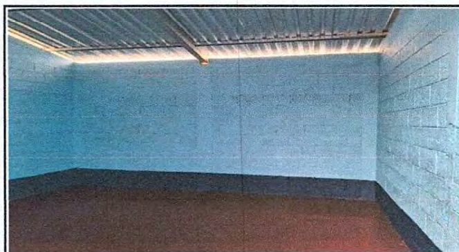
Foto 10: Pintura de paredes y torta de cemento en aula.
