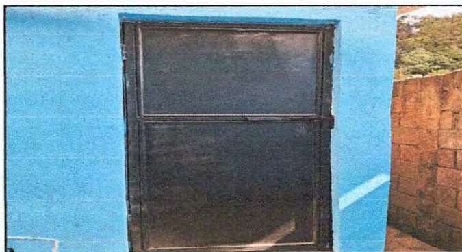
Foto 3: Instalación de puerta de baño.
