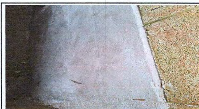
Foto 16: Repello de pared exterior.
