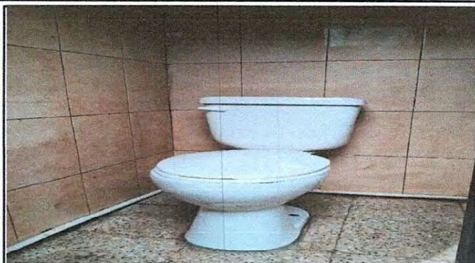
Foto 2: Trabajo de baño finalizado.
