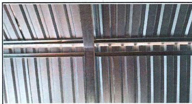
Foto 12: Instalación de costaneras y lámina.
