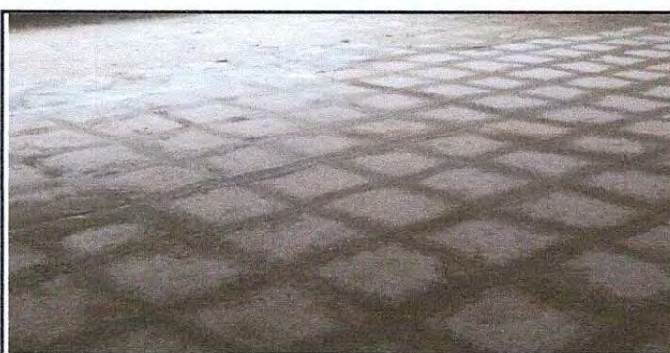
Foto 17: Colocación de piso granito.
