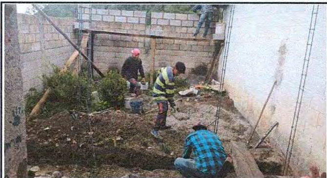
Foto 13: Inicio de construcción y mejoramiento de aula.
