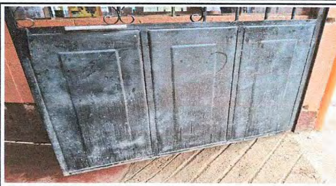
Foto 14: Lijado de puertas.
