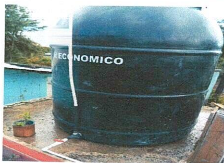
Foto 5: Sustitución de depósitos de agua
