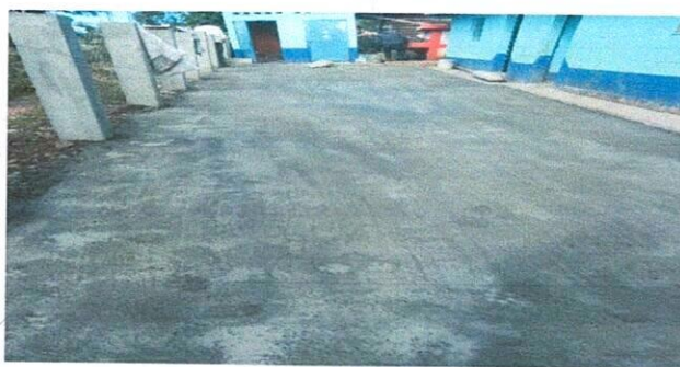
Foto 4: Reparación de planchas de concreto de patio
