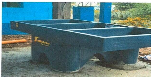
Foto7: Sustitución de pila, por pila plástica
