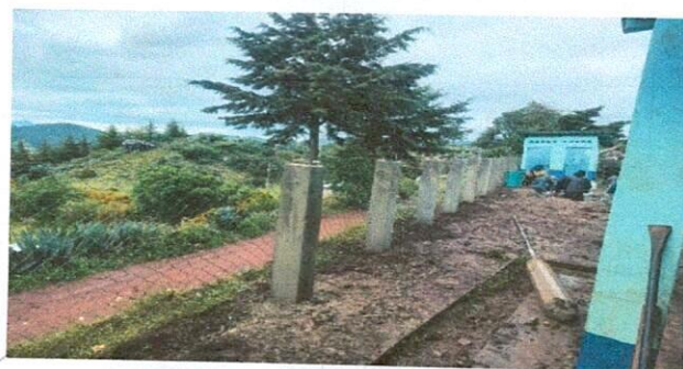
Foto 6: Reparación de muro perimetral
